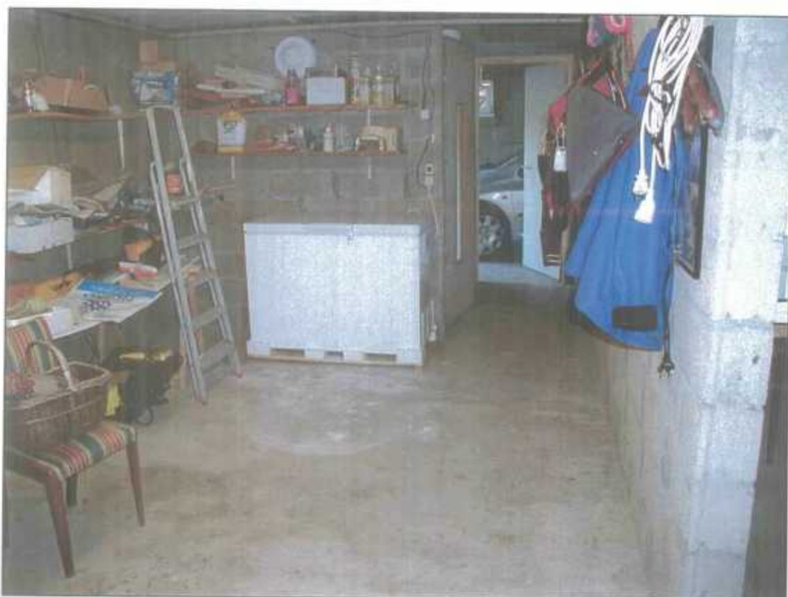
Photo 4 – Aperçu du sous-sol de l'occupant de la maison (parcelle AD 413). Habitué au phénomène, le propriétaire a surélevé le matériel sensible, on note ici l'exemple du congélateur.
