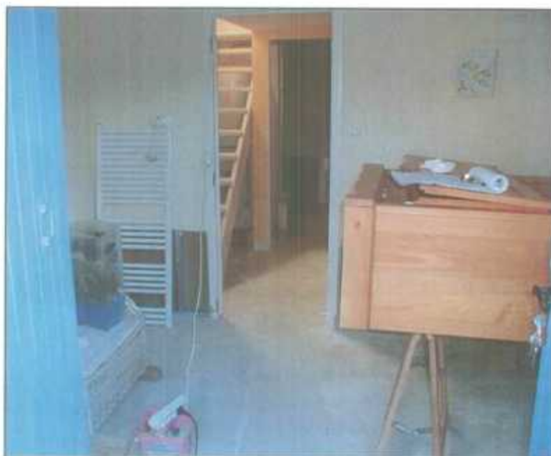
Photo 2 - Aperçu du sous-sol aménagé de la parcelle AD 199. On peut noter les dégâts survenus à la base du revêtement mural.
