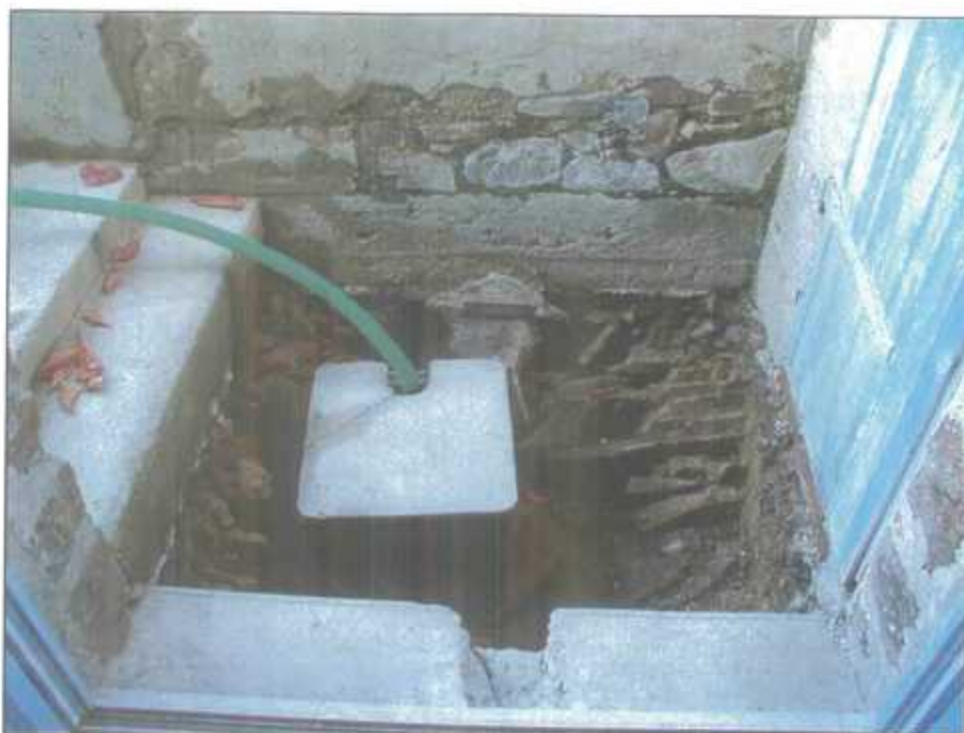
Photo 1 – Aperçu de l'excavation réalisée par le propriétaire de la Parcelle AD 199 à l'entrée du sous-sol et de la cuve renfermant la pompe. On aperçoit également très nettement la formation grés-schisteuse.
