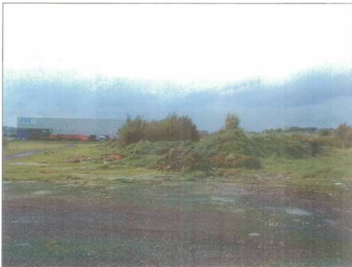
Prise de vue E-O (depuis le centre du site) : aperçu des terres de déblais.
