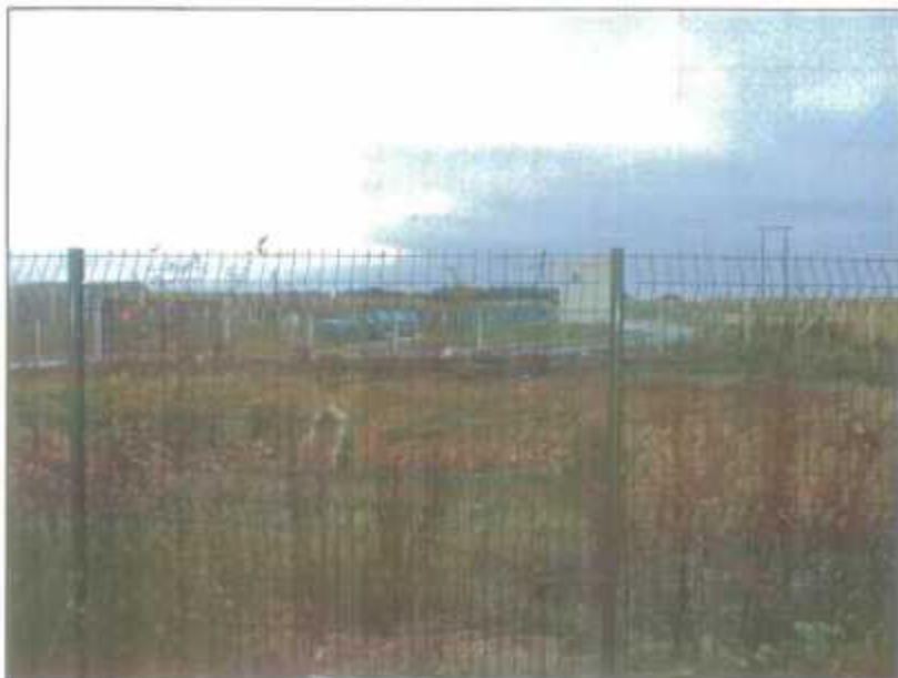
Prise de vue NO-SE (depuis RD 107) : aperçu du bassin d'eaux pluviales.
