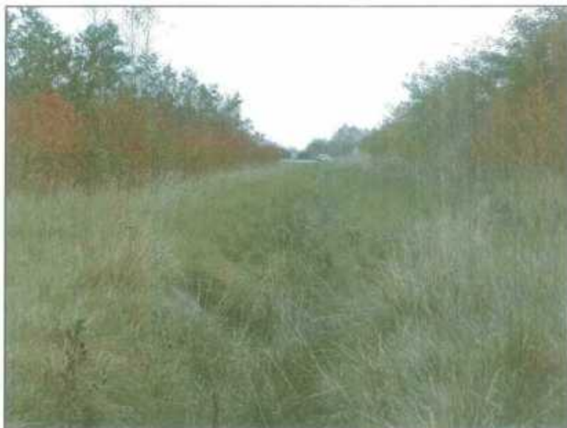
Prise de vue SO-NE : aperçu du caniveau enherbé le long de la RN29.
