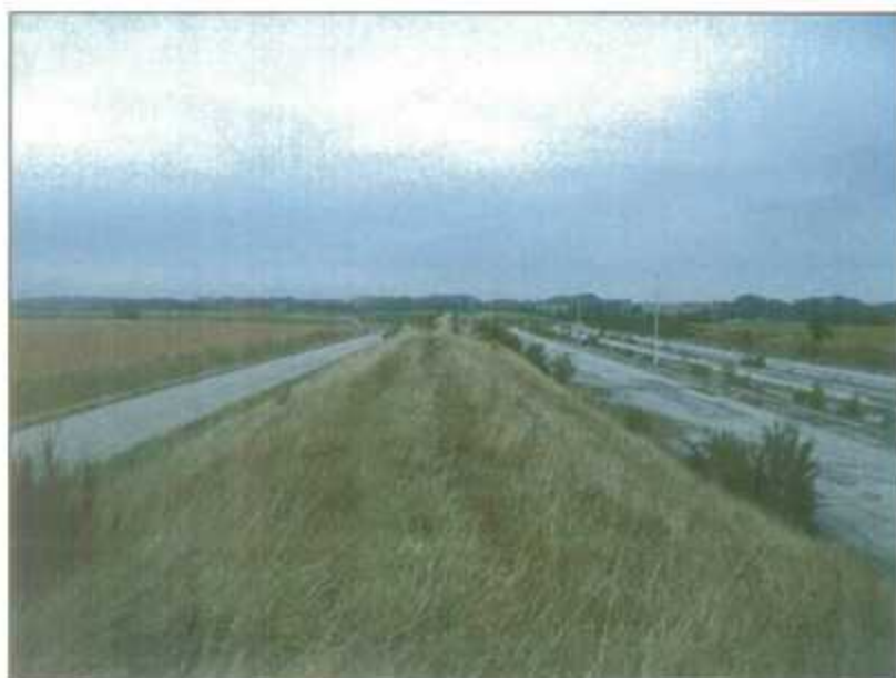
Prise de vue S-N (depuis la butte centrale) : aperçu de la route et de la voie ferrée hors d'usage.
