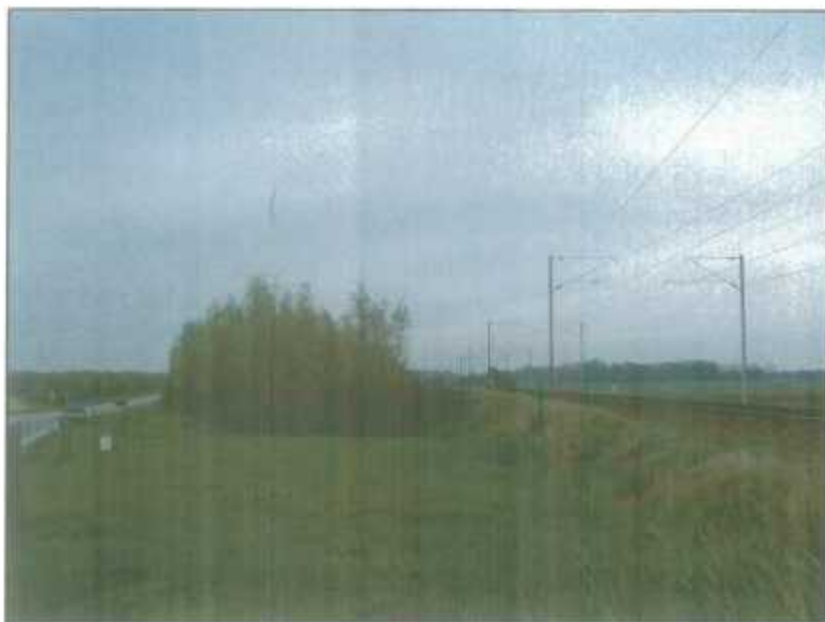
Prise de vue NE-SO (depuis l'intersection entre la RN29 et la voie ferrée).
