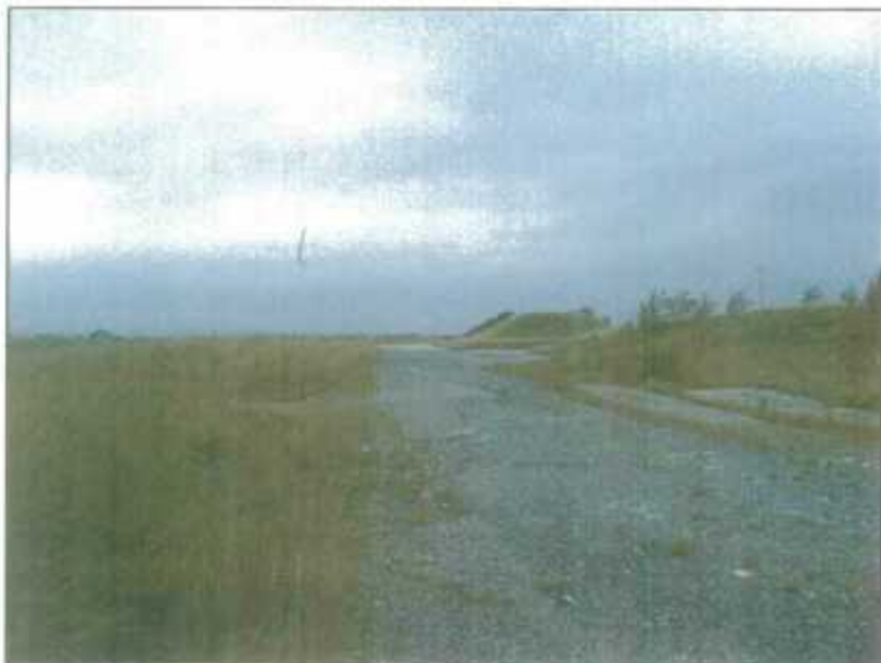
Prise de vue S-N (depuis l'accès par la RD 240).
