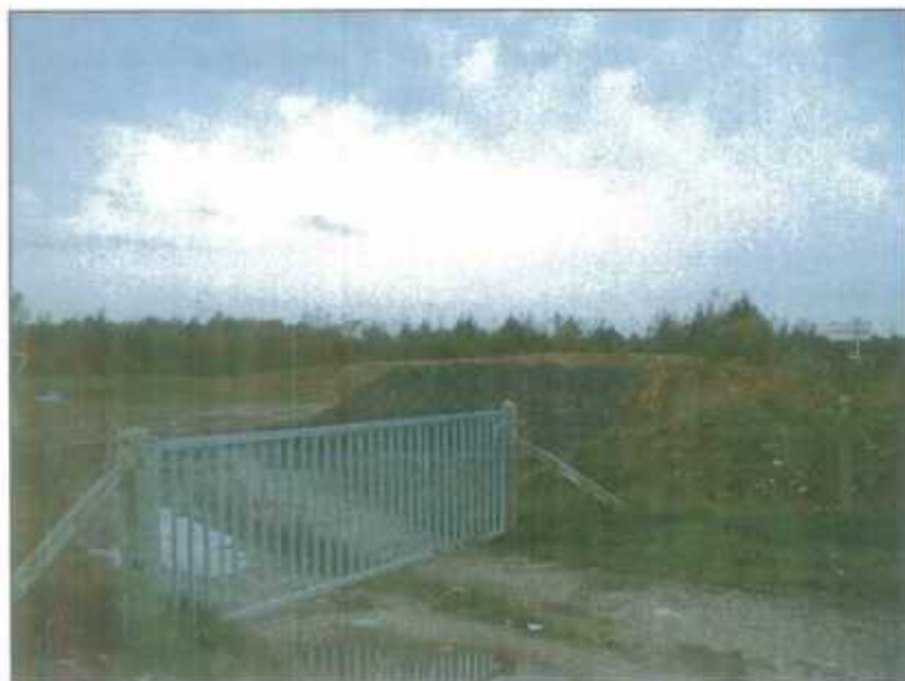
Prise de vue NO-SE (depuis l'accès par la rd 20) : aperçu des tas de granulats et de terre de déblai.
