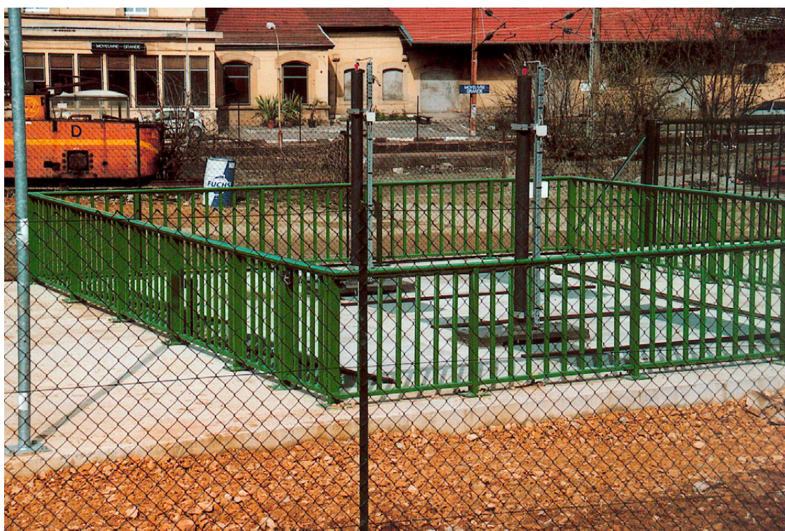
Photo 6 : Système d'ouverture et de fermeture des vannes
