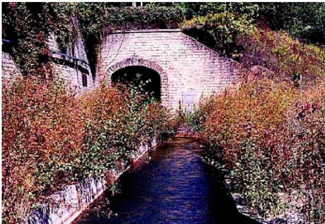
Photo 1 : Tunnel de débordement de Moyeuvre
