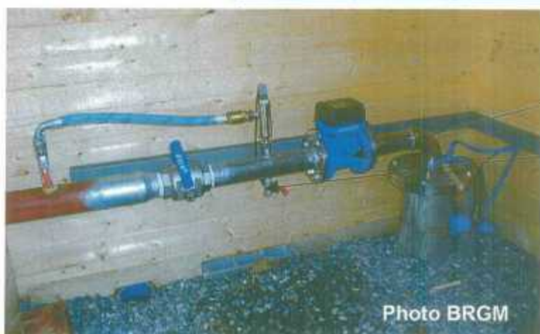
Equipements du local technique et tête de forage de Bois de Ville
