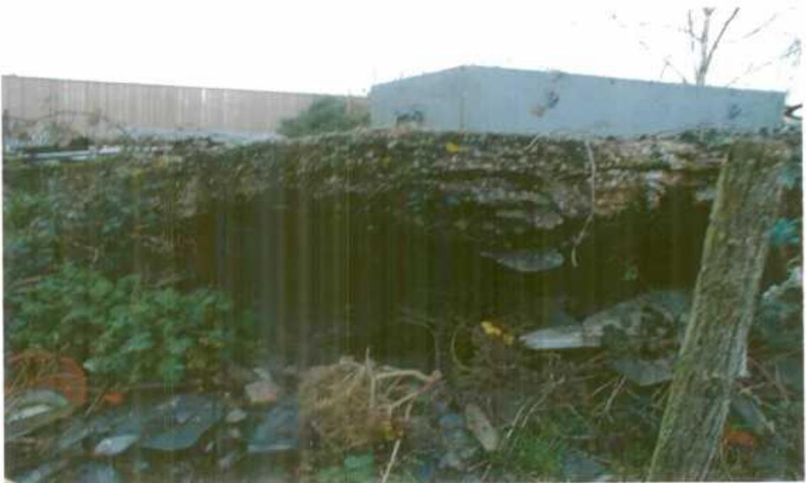
Photo 5 : Partie sous-cavée de la dalle du puits du Buisson à Saint-Saturnin-du-Limet
