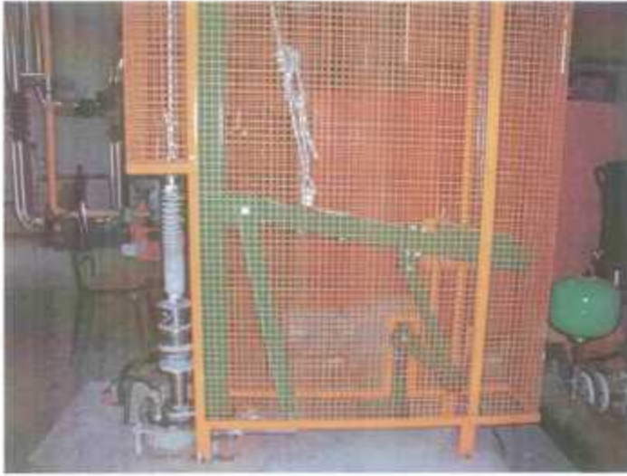
Source Duchesse (Tête d'ouvrage – pompe à piston)
