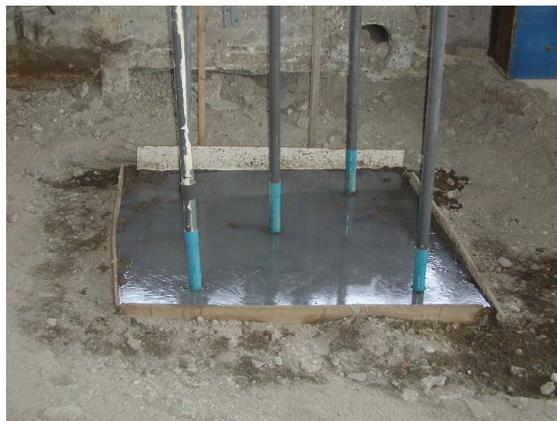
*Illustration 24 - Vue du pilote biogénique après la deuxième couche d'imperméabilisation réalisée le 12 août 2003*
