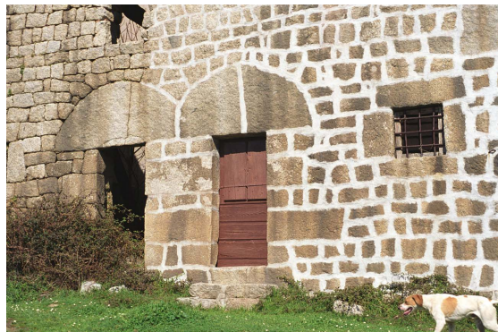
Photo 94 - Quenza : maison (détail) ; noter les éclats de boules en fronton de chaque porte
