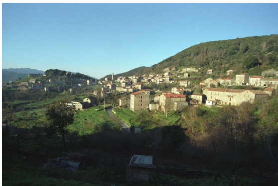
Photo 1 - Levie : vue générale
