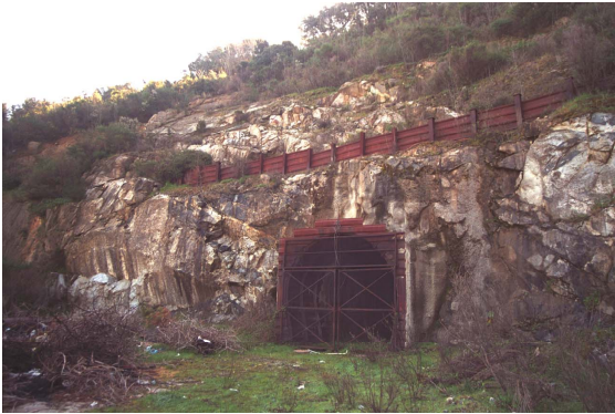
Photo 152 - Entrée de la galerie EDF
