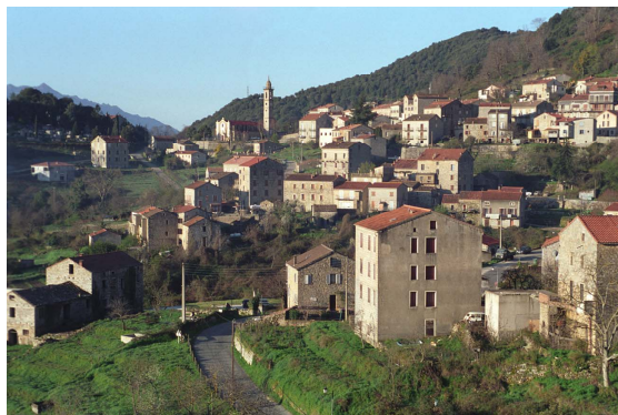
Photo 2 - Levie : vue générale
