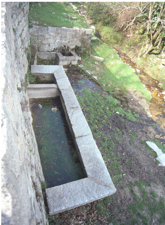
Photo 56 - Serra di Scopamena : le lavoir et la fontaine n° 8
