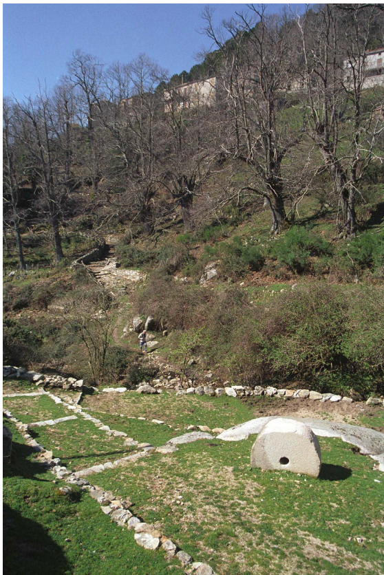
Photo 62 - Serra di Scopamena : meule et calade à restaurer devant le moulin
