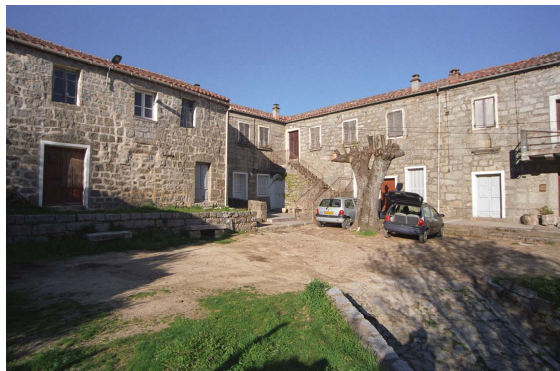
Photo 5 - Levie : placette privée dont le pavement est à restaurer
