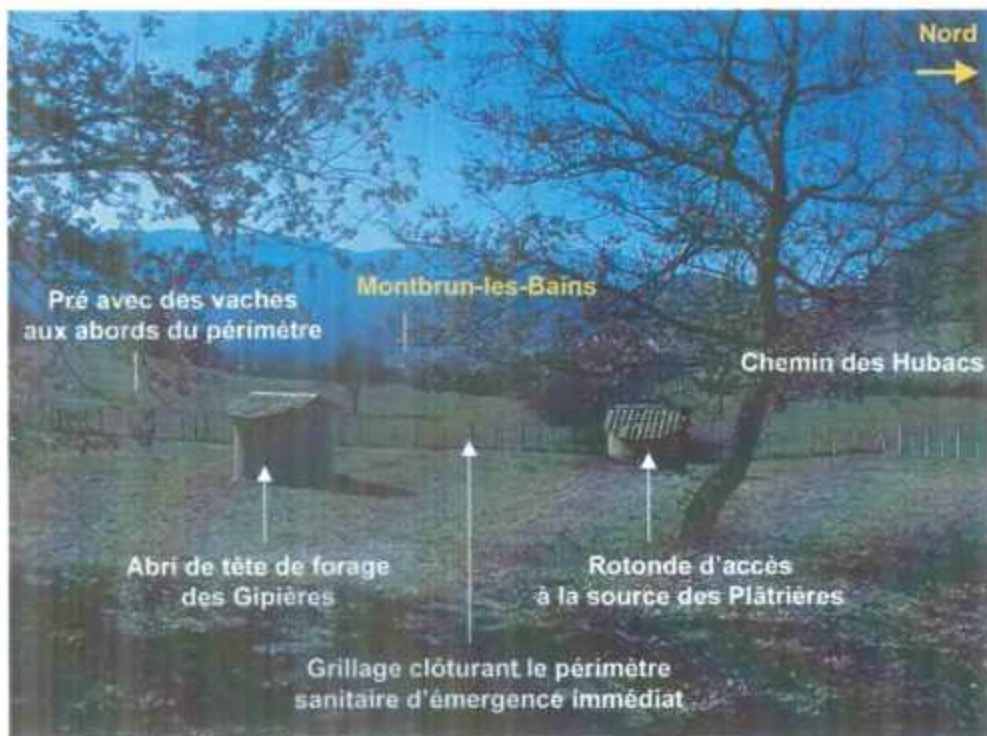
Vue générale du secteur thermal « des Plâtrières », vue vers l'ouest depuis la porte d'accès
