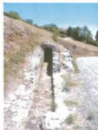
Figure 20 - Aqueduc romain du Gier : tunnel (à gauche) et tranchée couverte (à droite)
