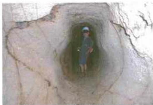
Figure 22 - Galerie d'adduction creusée dans du gore, sans soutènement (Les Ardillats)
