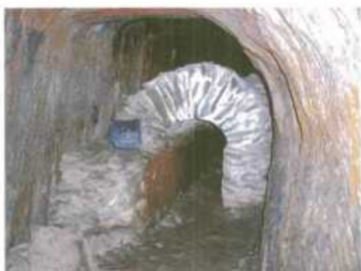
Figure 20 - Aqueduc romain du Gier : tunnel (à gauche) et tranchée couverte (à droite)
