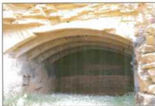
Figure 18 - Extension souterraine de 1000 m 3 dans une carrière de calcaire à Saint Germain sur l'Arbresle
