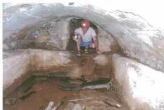
Figure 21 - Galerie se déversant dans une citerne (Eveux)
