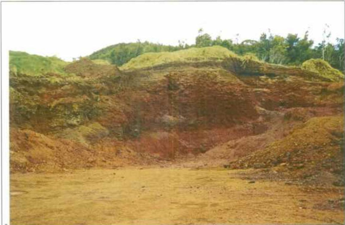
**Photographie 13 : Pouzzolanes de Piton Villers (commune du Tampon) - Vue partielle du front de taille de la carrière exploitée par la SBTPL**
