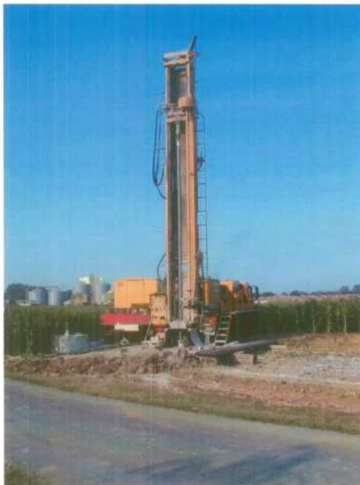
Figure 3 : Démarrage des travaux sur le site de Lezay.
