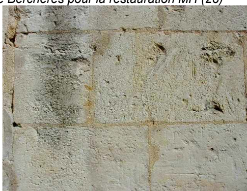
Pierre de Nogent-Le-Rotrou : échantillon et mur de l'église Saint-Hilaire à Nogent-Le-Rotrou (28)
