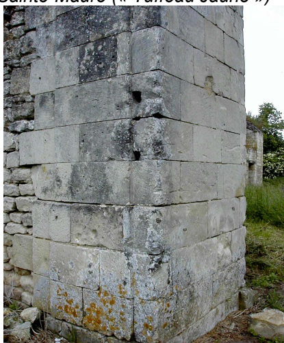
Tuffeau de Touraine : échantillon et contrefort de l'Abbaye de Bois-Aubry à Luzé (37)
