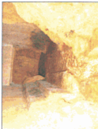
Vue sur le griffon principal situé au fond du captage
