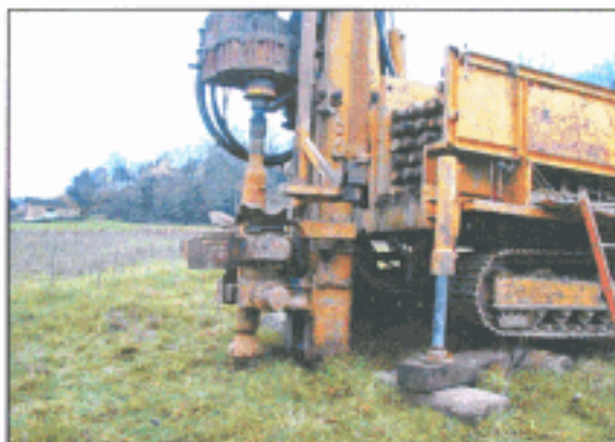
Mise en station
