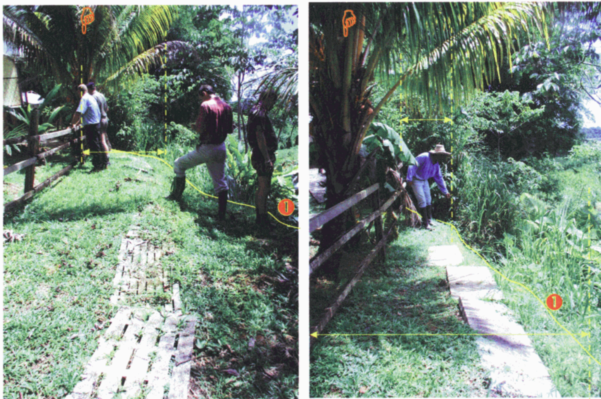
Figure 7 : Limite du talus depuis la clôture de la villa 115 D. ❶ tête de talus actuelle, la main (P) indique le palmier repère, noter le rétrécissement de la largeur entre la tête du talus et la clôture à partir du palmier.
