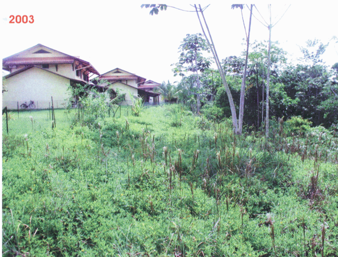
Figure 2 : Vue de la crête de talus en 2001 et 2003 sur la possible zone d'instabilité.
