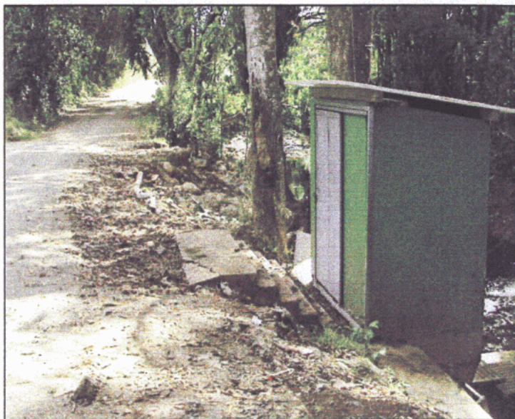
Photo 4: Seuil de Bouyouni-Bas, juin 2003. Photo Olivier Jossot, BRGM Mayotte
