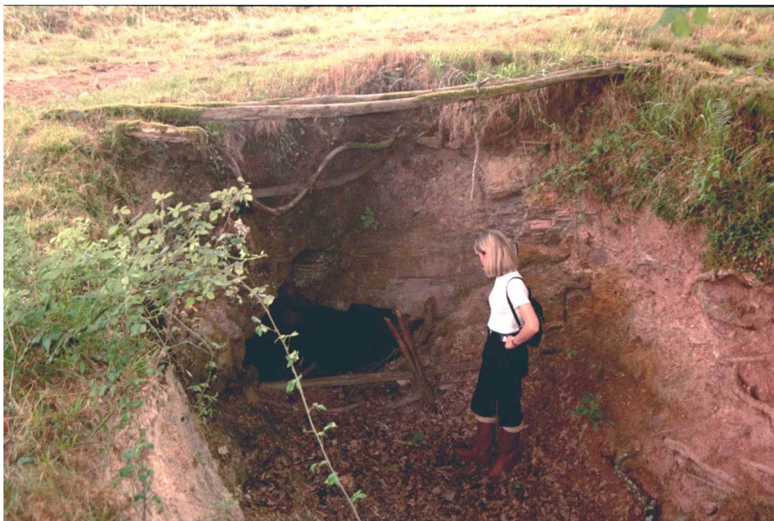
Photo 13 - Intérieur de la tranchée du site 13 avec l'entrée de la galerie à sécuriser.
