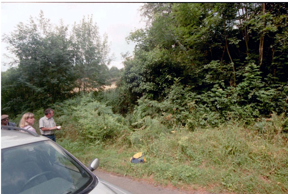
Photo 6 - Fontis au talus du VC6 (site 7).
