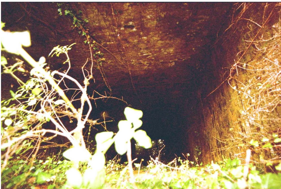
Photo 9 - Vue plongeante dans le puits Jeanne (site 9).
