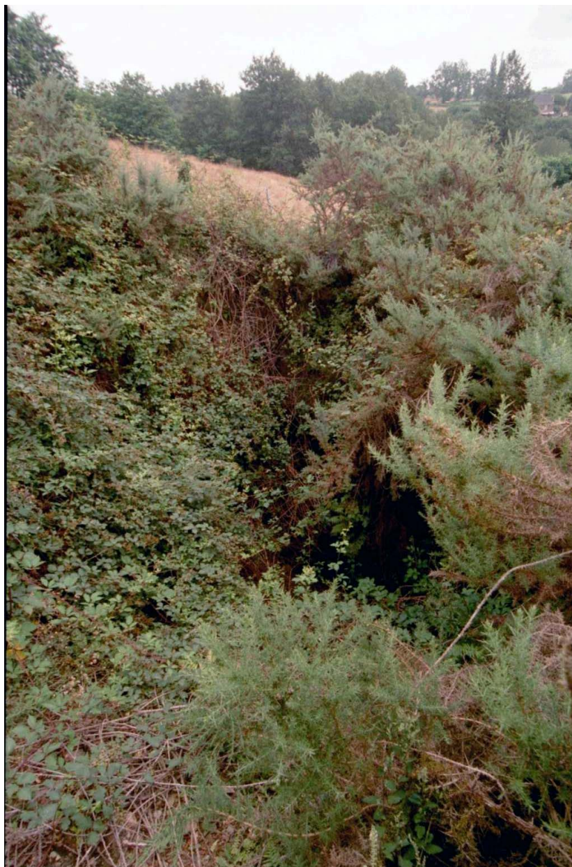
Photo 10 - Fontis sur la tête du puits n° 2 (site 10).
