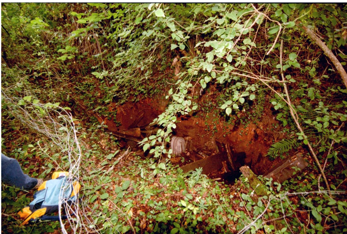
Photo 4 - Bouchon actuel improvisé du puits de Moulin Poudoux (site 5).
