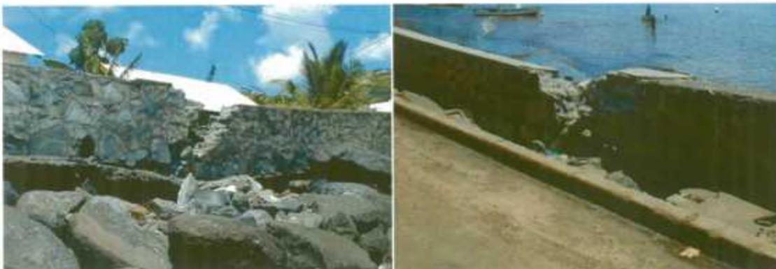
**Photographie 8 – Destruction du mur de protection du village de Majikavo-Koropa. Côté-mer, l'affaissement de l'enrochement crée un affouillement en pied de mur qui se traduit par la rupture du mur et, côté-terre, par le basculement du trottoir (mission 2003, BRGM).**
