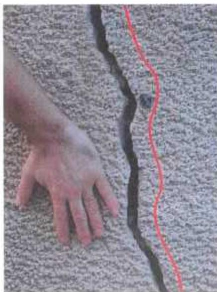
**Photo Girecourt 4 – Château - Tour fissurée - Fissure préexistante élargie – Détail**
