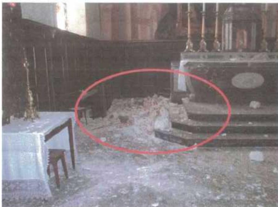
photo Deneuvre 3- dommages à l'intérieur de l'église dommage au stuc
