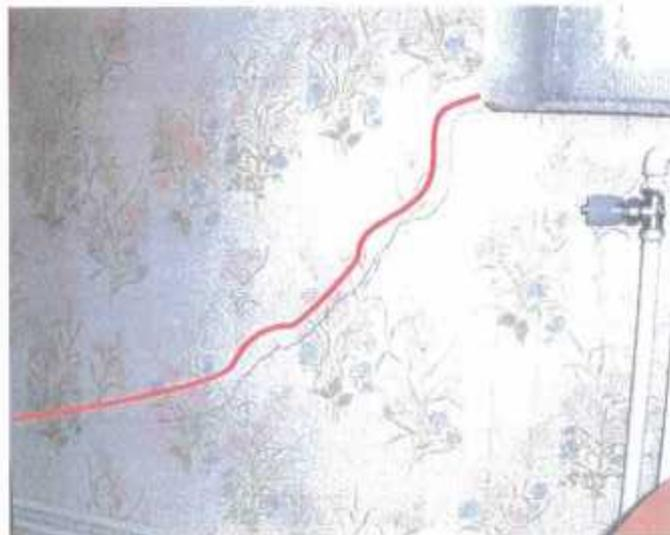
**Photo Jeanménil 7 – Fissuration importante en coin de fenêtre – Façade Ouest**
