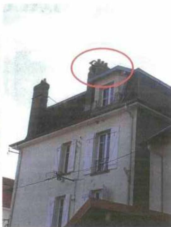
**photo Baccarat 2 : dommages sur des cheminées, concentrés sur la rive gauche de la Meurthe.**
