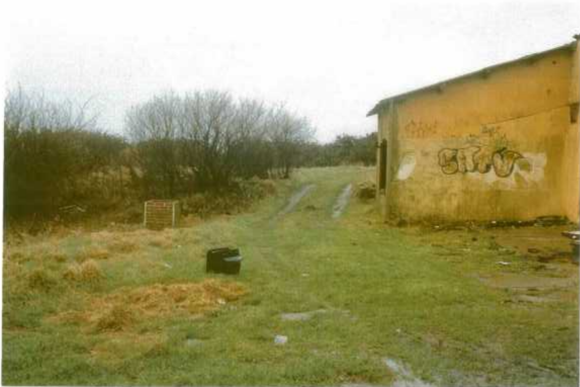
Photo 1 : Vue de la maison d'habitation située à 12 – 15 m ( ?) environ de la falaise, parcelle ZR185, commune d'Octeville-sur-Mer (76).
