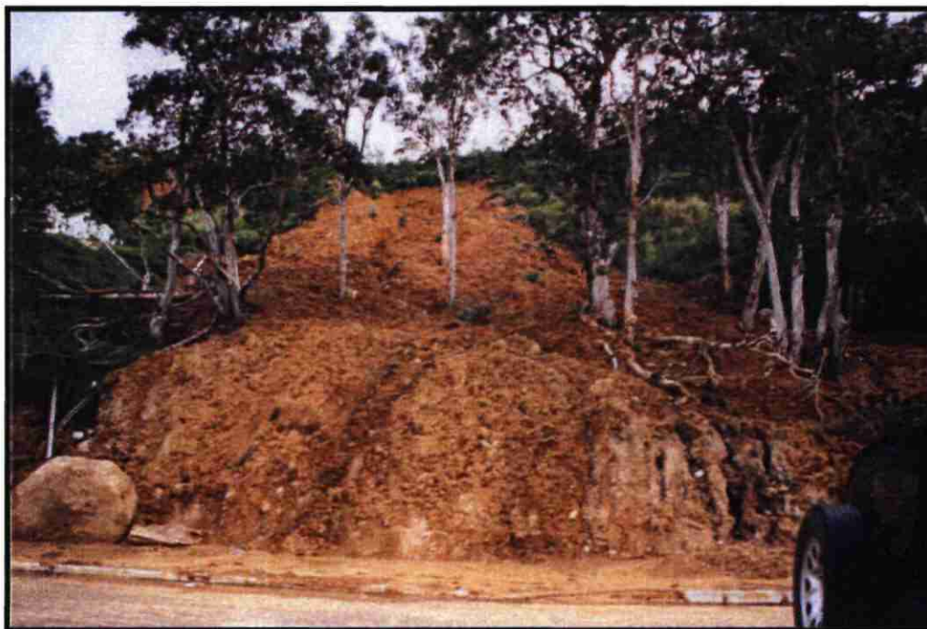
Fig. 31 – Glissement de Nondoué : Vue depuis le bas
