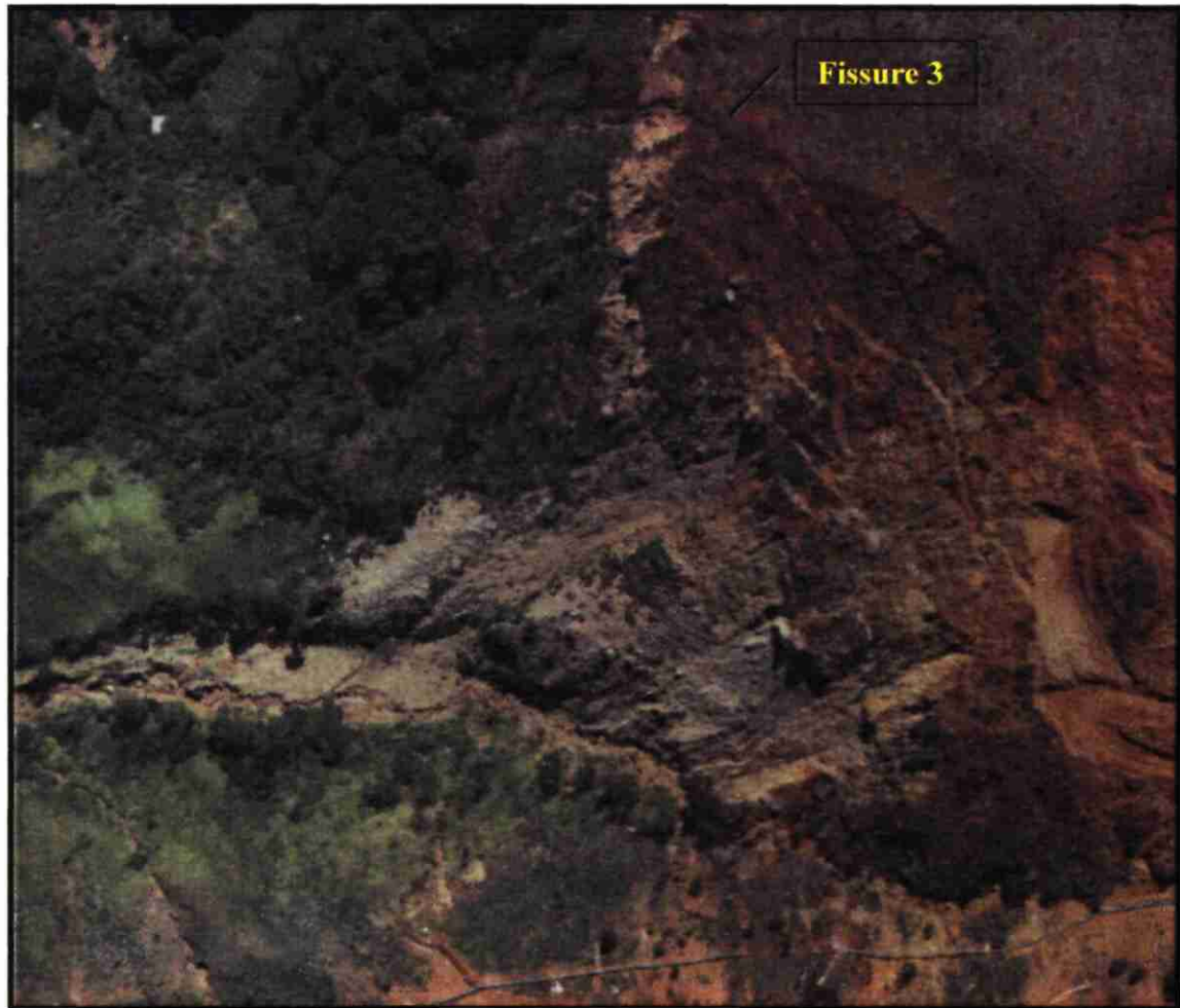
Fig. 8 – Vue aérienne de la zone du glissement en 1990
