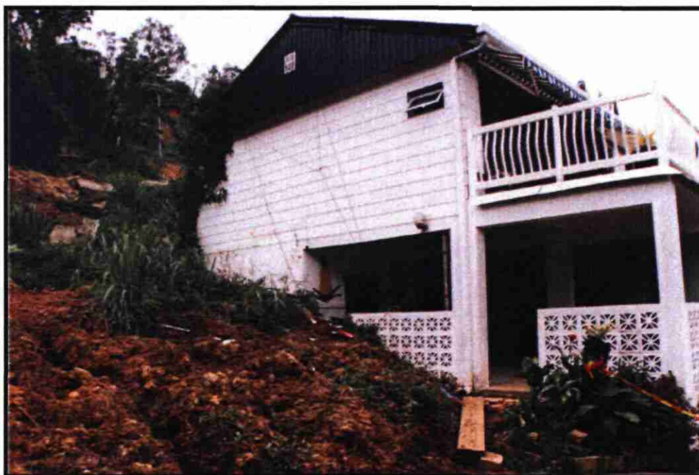
Fig. 25 – Glissement de Yahoué : l'habitation la plus en aval, recouverte par la coulée boueuse.
