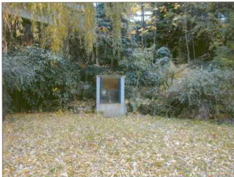
Photo 4 : Construction protégeant le forage César
