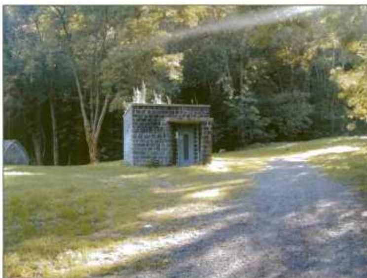
Photo 12 : Infrastructure protégeant le captage de Bonnefont
