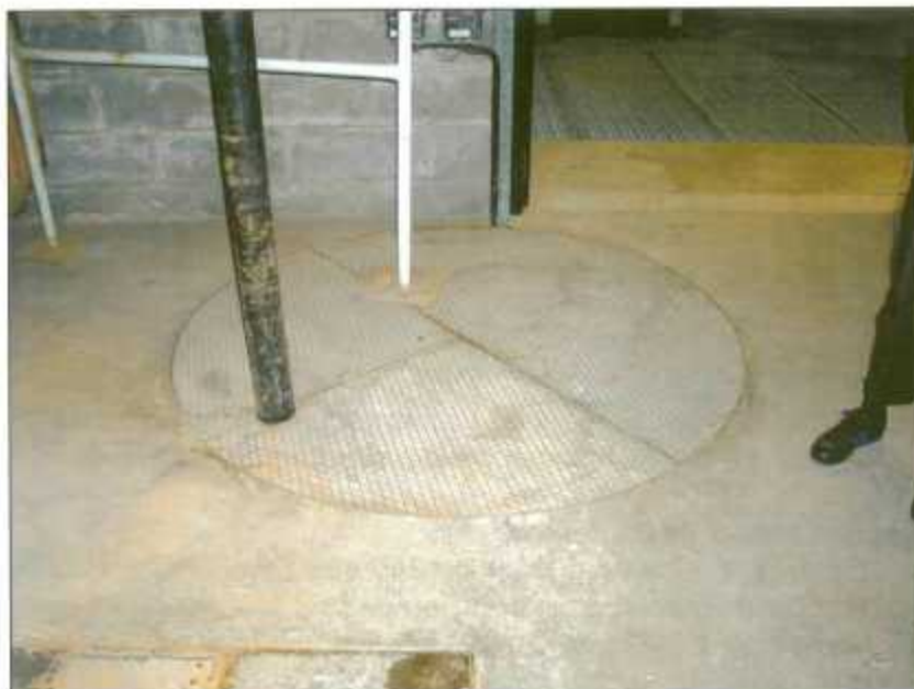
Photo 6 : Tôle métallique surmontant le puits Saint-Mart
