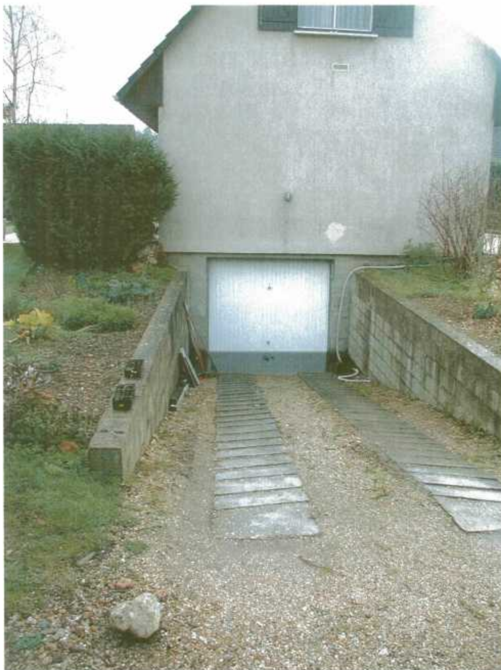
Photo 1 - Débordement phréatique actif en sous-sol depuis mars 2000. La fissure horizontale sur le mur au-dessus du garage semble ancienne et n'a pas joué de manière significative. Commune de Glisolles (27), décembre 2002.
