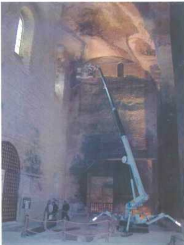
Photo 1 – Nacelle élévatrice dans la nef
