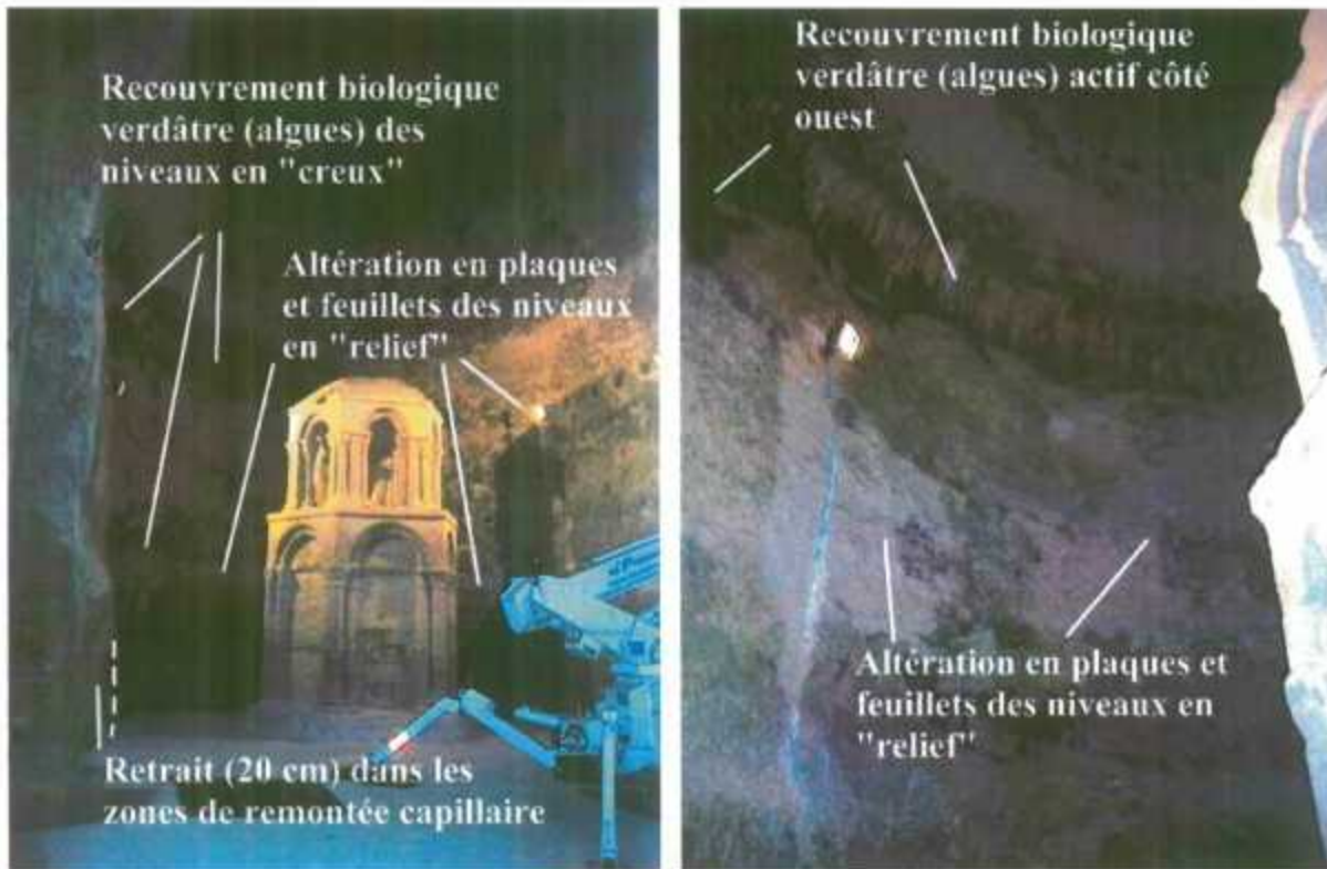
Photos 29 & 30 – Eglise médiévale - Abside - Recouvrement biologique verdâtre (algues) actif côté ouest et "fossile" côté est - Alternance de niveaux en creux (à recouvrement biologique) et en "relief" (à altération en plaques et feuilletés).
