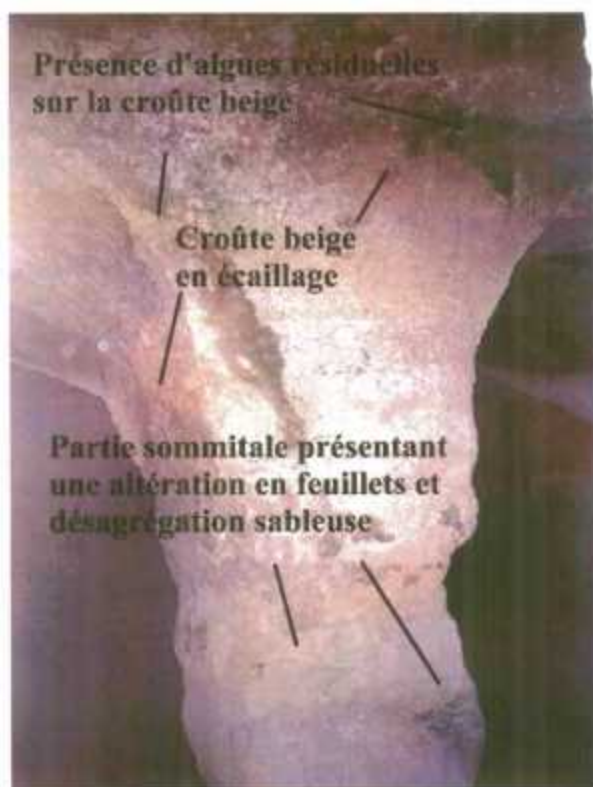
Photos 32 à 34 – Eglise médiévale - Piliers "centraux"- Partie basale et intermédiaire à surface bien conservée - Partie sommitale à altération en feuillets et désagrégation sableuse - Présence d'une croûte résiduelle beige en cours d'écaillage.
