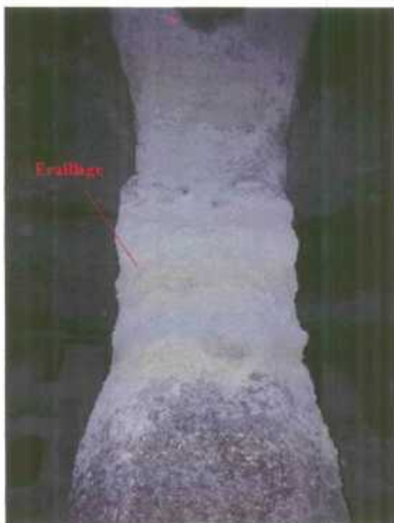
Photo 11 – Pilier Sud – phénomène d'écaillage à la naissance de la voûte
