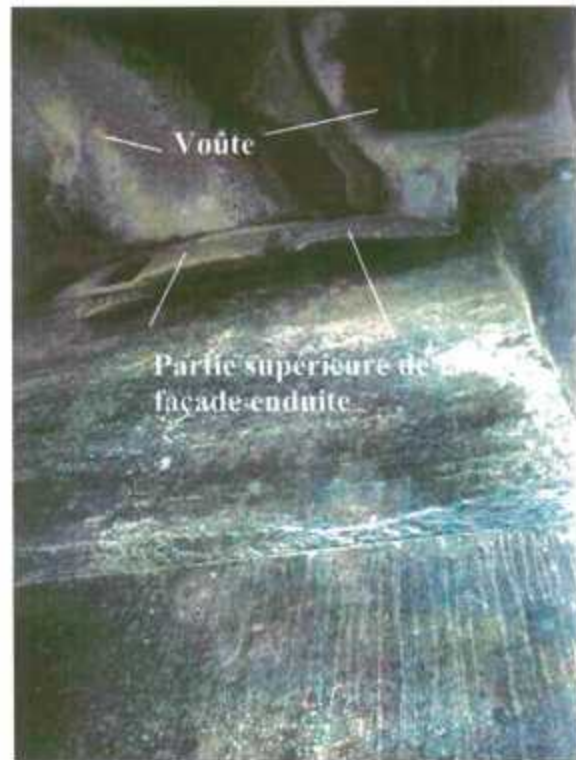
Photos 15 à 17 - Eglise médiévale - Façade sud - Croûte biologique noirâtre recouvrant la façade - Développement d'algues plus marqué à proximité des sources lumineuses (lampe au sol et fenêtre de la façade est)
