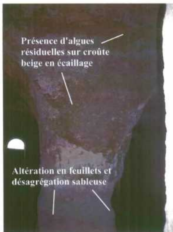
Photos 32 à 34 – Eglise médiévale - Piliers "centraux"- Partie basale et intermédiaire à surface bien conservée - Partie sommitale à altération en feuillets et désagrégation sableuse - Présence d'une croûte résiduelle beige en cours d'écaillage.
