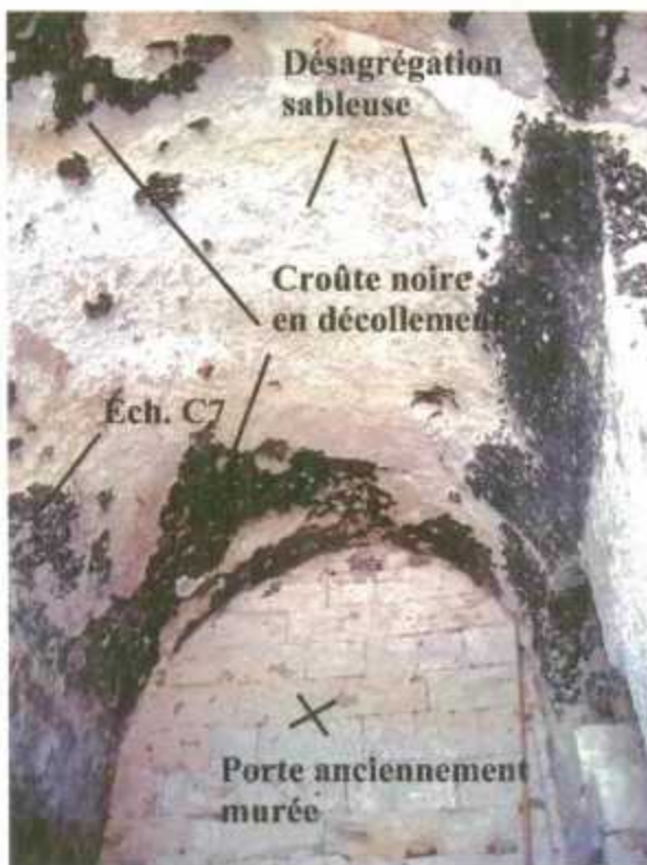
Photos 40 à 42 - Eglise médiévale - Façade Est - Galerie d'accès sud - Voûte à croûte noire en décollement - Désagrégation sableuse dans les zones "décollées" - Alvéolisation des moellons et de la paroi naturelle.
