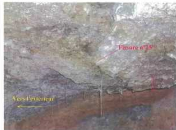
Photo 8 – Voûte de la nef - rejet vertical sur la fissure n°25''
