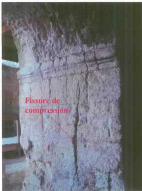
Photos 2 et 3 – Effets des mécanismes de compression sur le parement sud du transept nord
