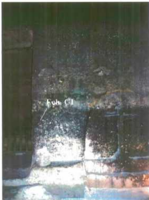
Photos 15 à 17 - Eglise médiévale - Façade sud - Croûte biologique noirâtre recouvrant la façade - Développement d'algues plus marqué à proximité des sources lumineuses (lampe au sol et fenêtre de la façade est)
