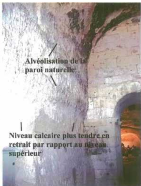
Photos 40 à 42 - Eglise médiévale - Façade Est - Galerie d'accès sud - Voûte à croûte noire en décollement - Désagrégation sableuse dans les zones "décollées" - Alvéolisation des moellons et de la paroi naturelle.
