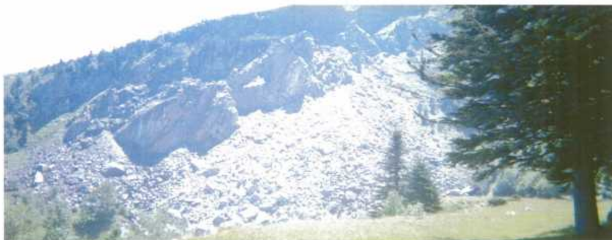
Photo 3 : Effondrement rocheux de la carrière de Fangas, vue de face
