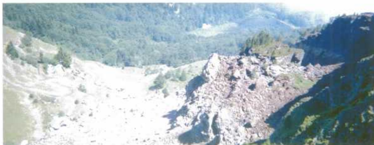
Photo 4 : Effondrement rocheux de la carrière de Fangas, vue depuis la crête
