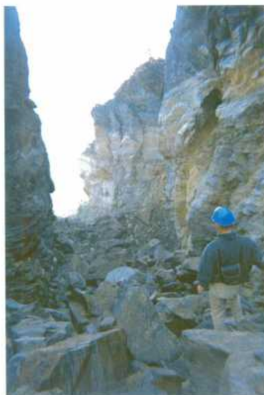
Photo 7 : Dans la niche d'arrachement Nord de l'effondrement rocheux ; à gauche, la masse en cours d'effondrement, à droite la couronne de l'effondrement très instable dans ce secteur.
