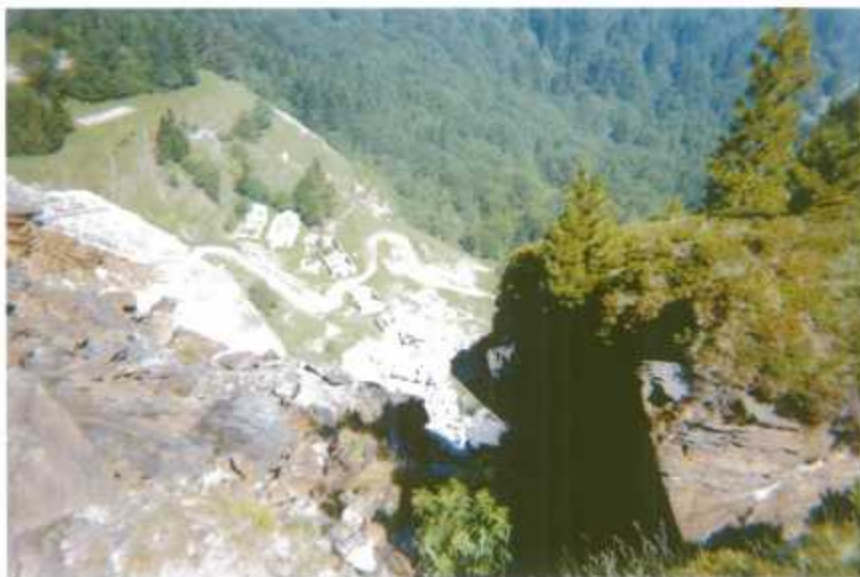
Photo 6 : Aperçu sur les blocs déstructurés sur la partie frontale de l'effondrement; en bas le sentier, les anciens bâtiments de la carrière et l'éboulement de mai 2002.
