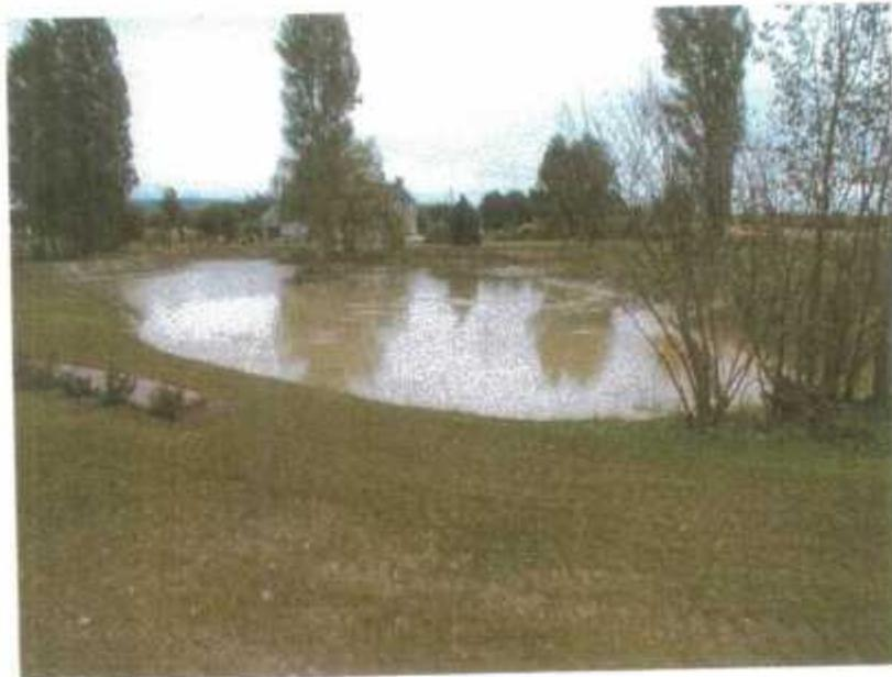
*Photo 2 : Vue générale du plan d'eau créé, en partie par excavation, en partie par remblais, sans bêche ni ouvrage de déverse de crue visible, mettant à l'affleurement l'aquifère calcaire captée pour l'AEP, commune d'Aubry-en-Exmes (61).*
