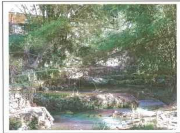
Vue prise à la hauteur du quartier Koualé : Laises de crue de la rivière Koualé (hauteur environ 3,5 m) ; Travaux réalisés dans le lit mineur de la rivière (épis, mur de soutènement du versant).
