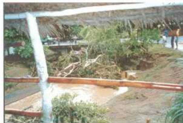
Exemple d'embâcle de branchages sous le pont de Bandré, le 7 mars 2001. © F. Bouffery.
