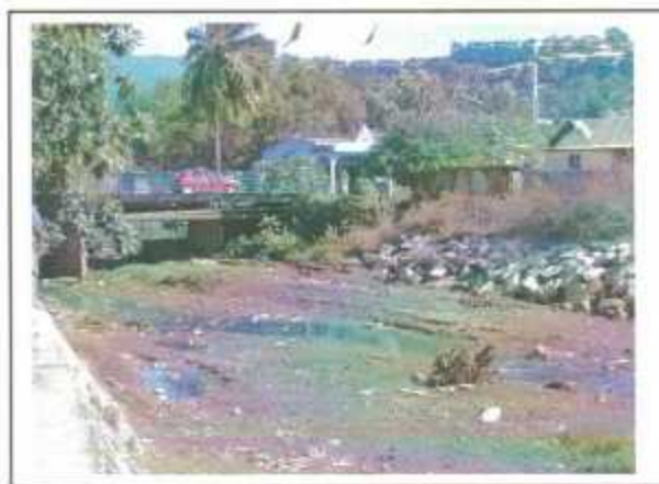
Vue vers l'amont à 300 m de l'estuaire de la Majimbini. Les maisons seront rapidement inondées en cas de crues. Les branchages et les carcasses de voitures laissées à l'abandon dans le lit mineur peuvent également former des embâcles et obstruer le passage sous le pont de la RN. En 2002, une passerelle en bois a été emportée par la rivière en crue, 200 m en amont de ce pont. Des laisses de crues sont observées sur les piles à 2 m au dessus du fond du lit mineur.
