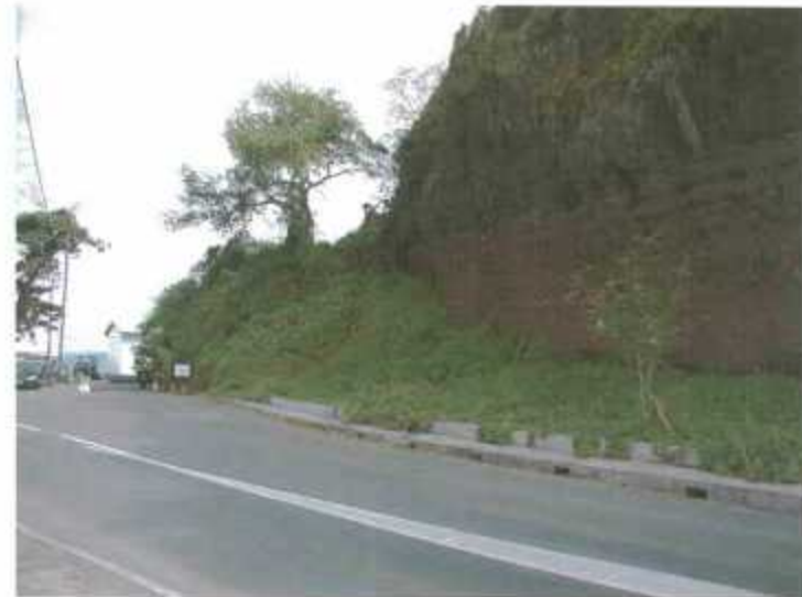
Exemples de chutes de blocs : falaise du Rocher en Petite-Terre
