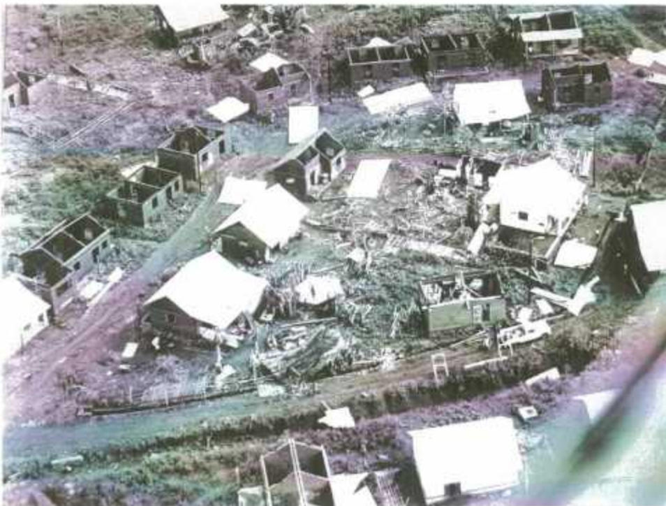
Fig. 19 – Dégâts dans un lotissement de Sada après le passage de Kamisy en 1984 Les cases traditionnelles sont à terre et les toitures métalliques des maisons en dur ont été emportées (Source Météo-France, 1984).
