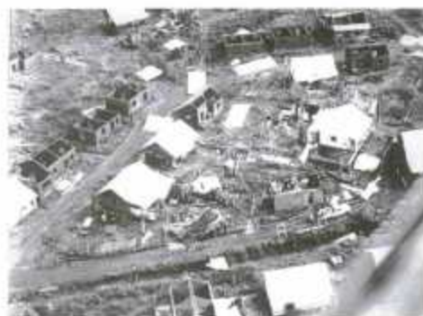
Loisierement détruit après le passage de Kamisy (1984)
