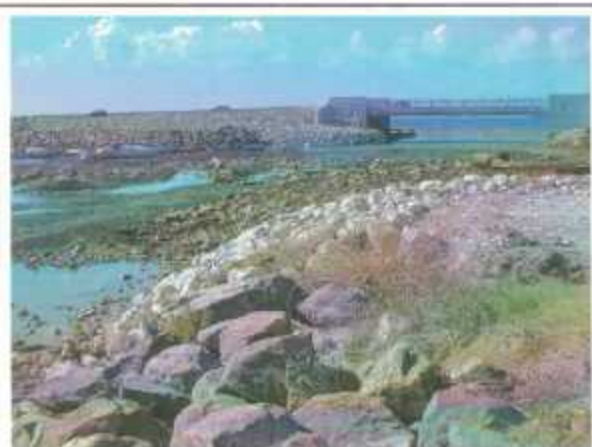
Vue de l'estuaire de la Majimbini à marée basse le 04/06/02. L'estuaire a été réaménagé en 2002 pour la construction de la déviation de Mtsapéré (pont).
