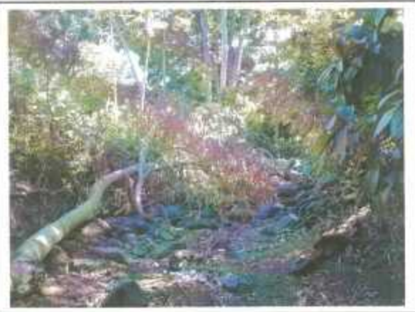
Vue prise à environ 1,4 km de l'estuaire de la Kaouenilajoli (le 06/06/02) : le lit mineur est encombré de troncs d'arbres et de gros blocs de basalte qui peuvent constituer des embâcles. Les laisses de crues observées dans ce secteur sont à 4 m au dessus du lit mineur.
