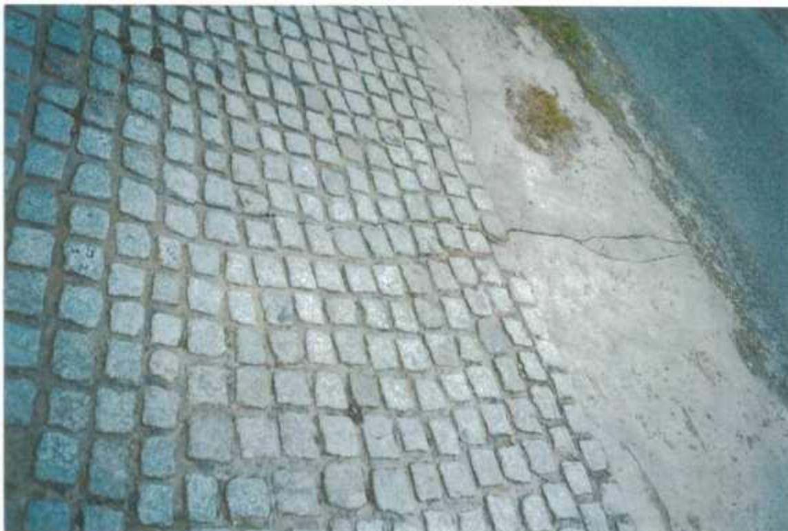
Photo 5 - Une des fissures résiduelles au sol des abords du bâtiment parcelle ZC45, commune de Epreville-en-Lieuvin (27).
