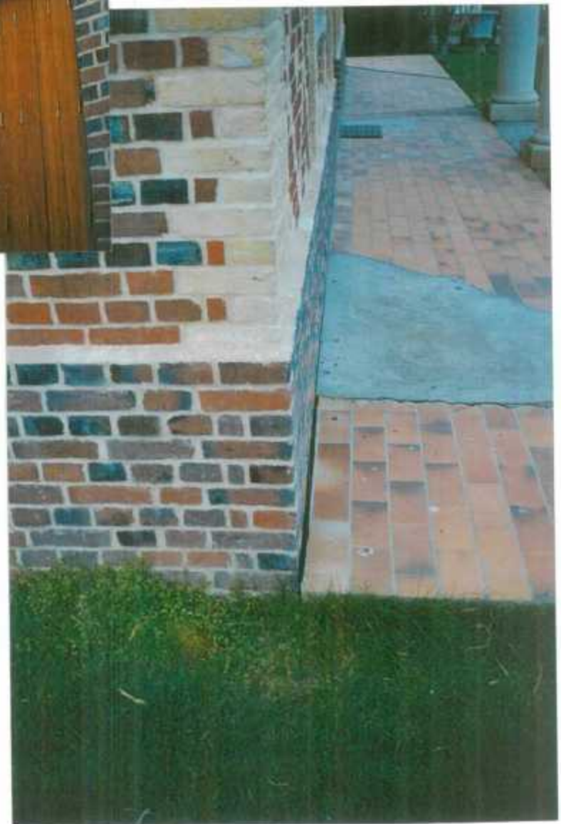
Photo 3 - Fissure (rebouchée au mortier blanc) concernant toute la hauteur du bâtiment parcelle ZC45, commune de Epreville-en-Lieuvin (27).
