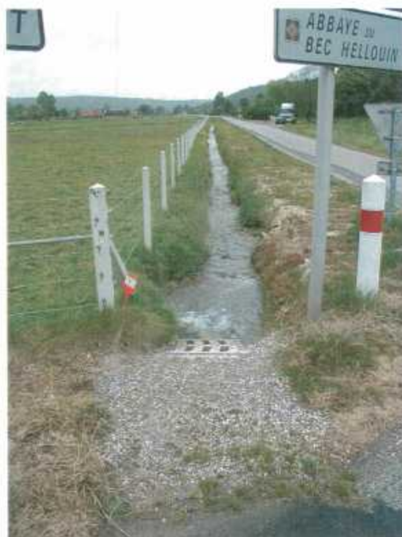
Photo 10-Vue de l'important flux écoulement phréatique en sortie d'exutoire fin mai 2002, au débouché des deux thalwegs de La Haye-de-Calleville et du Trou Tassin. Cet ouvrage hydraulique a du être rajouté au carrefour routier, du fait de la pérennisation de l'émergence. Commune de La-Neuville-du-Bosc, (27).
