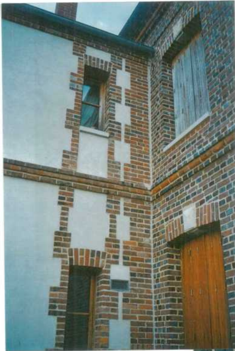
Photo 3 - Fissure (rebouchée au mortier blanc) concernant toute la hauteur du bâtiment parcelle ZC45, commune de Epreville-en-Lieuvin (27).
