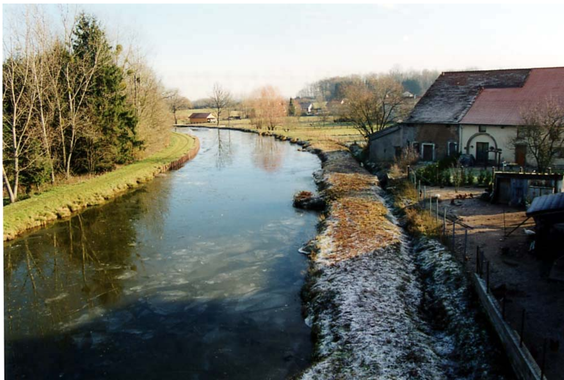
Photo 9 : Canal de l'Est branche Sud au niveau de Sanchey. Un axe de circulations touristiques
