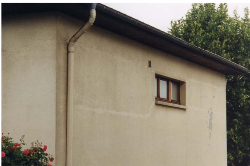
Fissures horizontales
