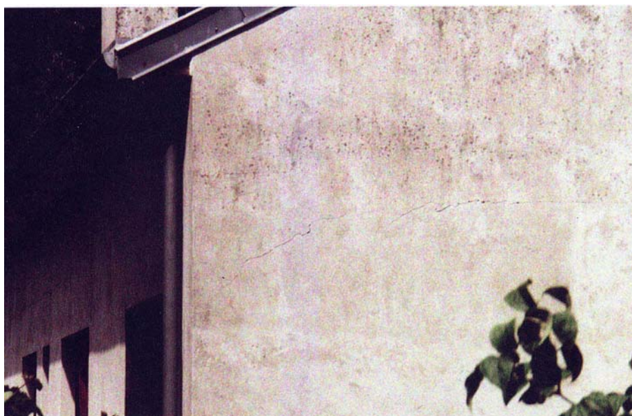
Fissure horizontale rectiligne et continue
