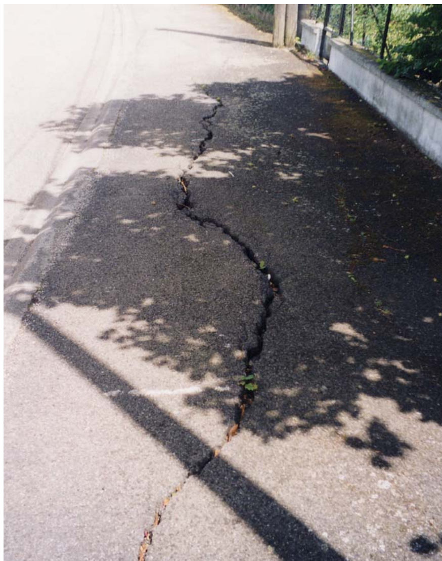
Fissure ouverte dans la chaussée suite à un affaissement
