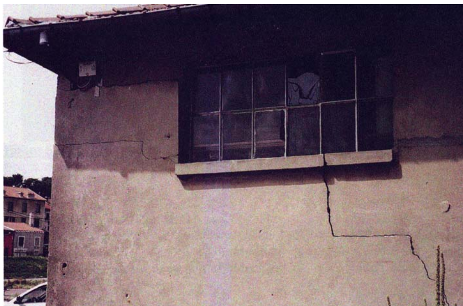
Fissure oblique et horizontale
