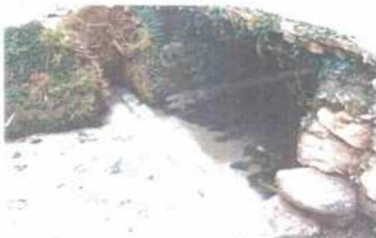
Réalisation d'un Seuil dans le lit sec du cours d'eau
