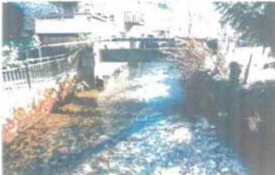
Terrassement du lit en écoulement pour mise en place de la poutre
