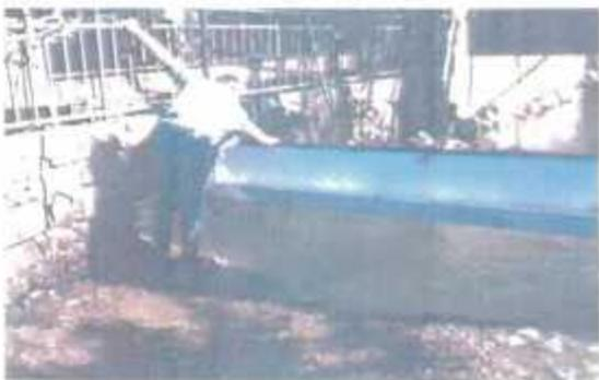
Contrôle sous l'eau de l'horizontalité de la poutre
