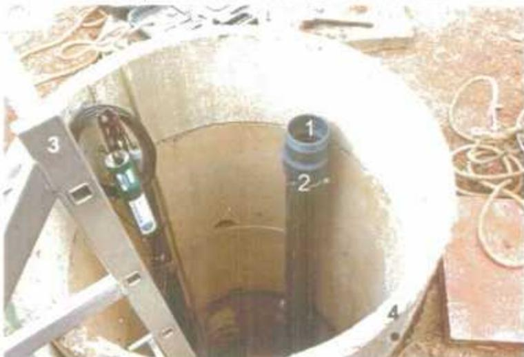
1 : manchon collé avec filetage "gaz" pour vissage d'un obturateur
