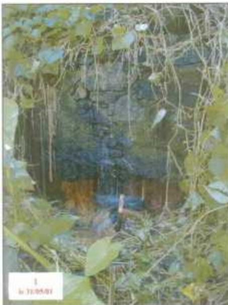
Photo 1 : Ancien captage de la source Mare à Goyaves (1227-5X-0064). Il est à noter que l'émergence se fait au toit d'une formation pyroclastique (brèche explosive cendreuse de couleur rouge).
