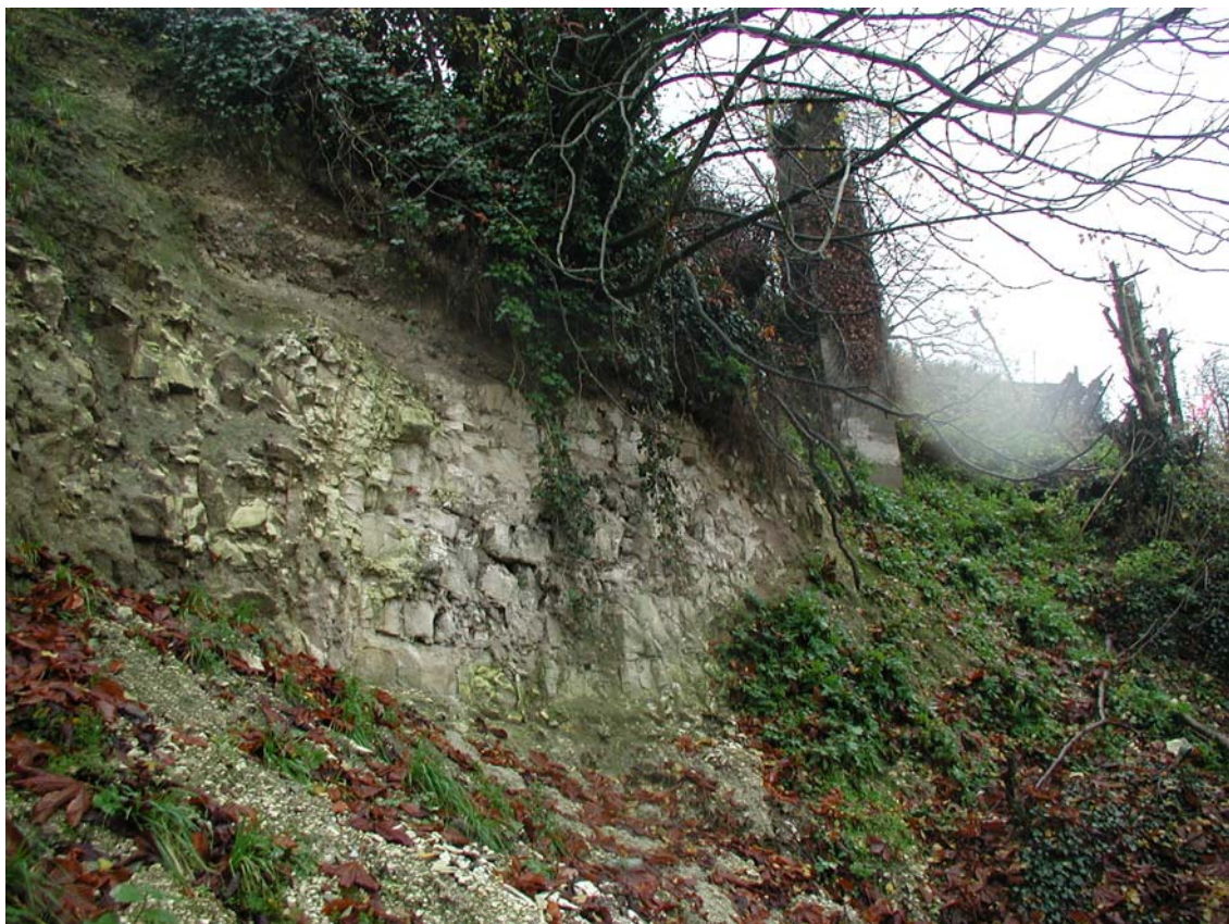
Fig. 21 – Falaise crayeuse dégagée par le glissement de remblais au-dessus du 46, rue des Tanneries (cheminée d'aérage à l'arrière plan)
