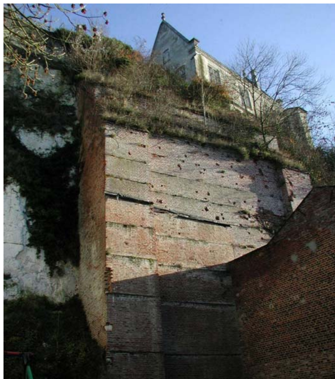
Fig. 8 – Murs de soutènement en briques constituant un bastion sous le Prieuré
