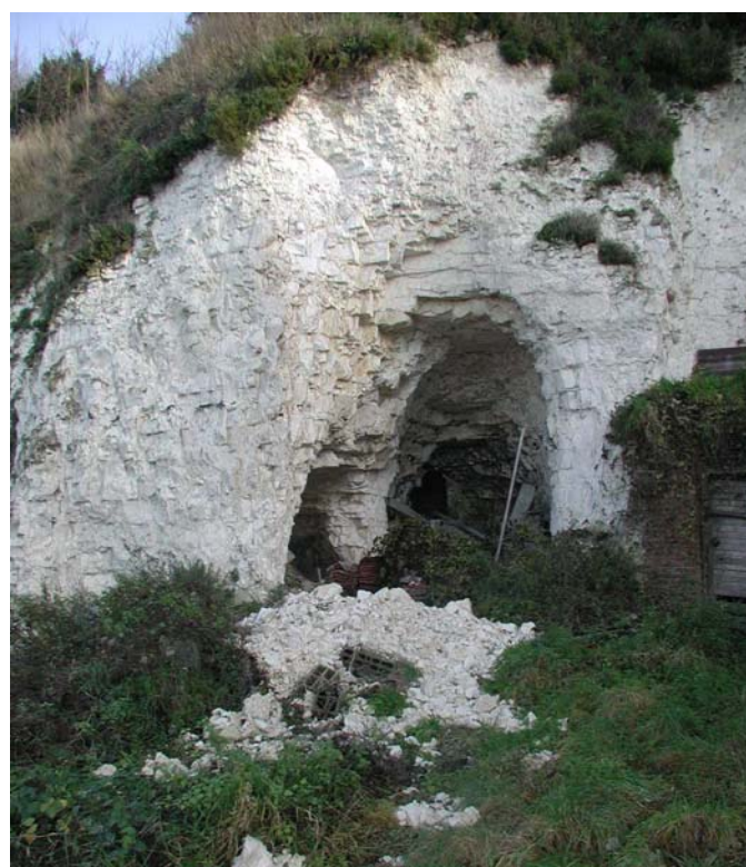
Fig. 9 – Eboulement survenu en 2001 au droit des bouches de cavage situées rue Adrien de la Morlière, sous l'église Saint-Pierre
