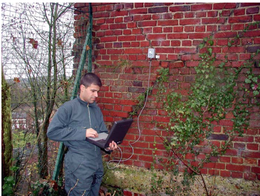
Fig. 23 – Capteur de déplacements (type 1) à l'extrémité du mur dans la cour de l'annexe du collège Saint Vincent
