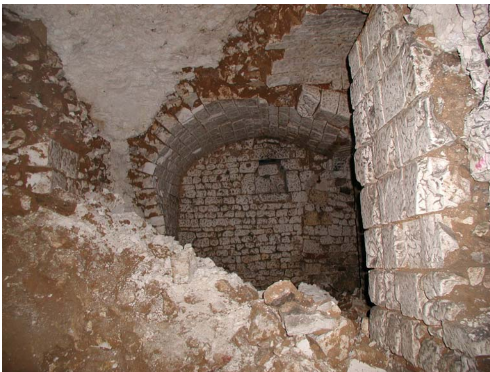
Fig. 17 – Niveau supérieur du souterrain situé rue Jean de la Villette
