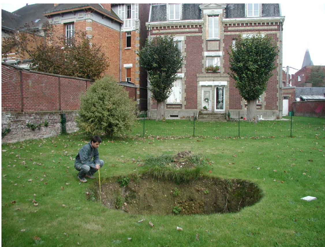
Fig. 16 – Effondrement de cavité souterraine sous la pelouse du 1, rue Cauvel de Beauvillé
