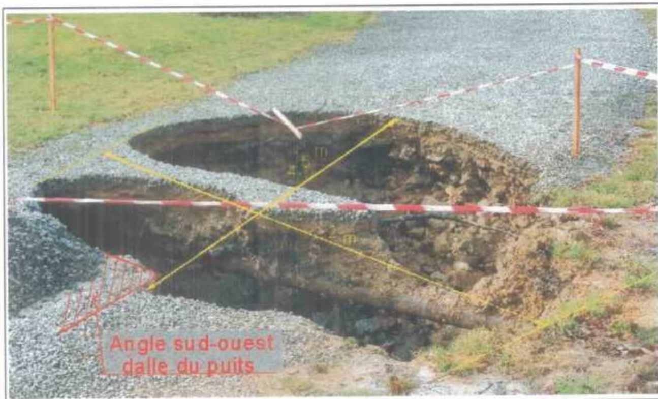
Vues de l'effondrement dans son contexte, et en détail
