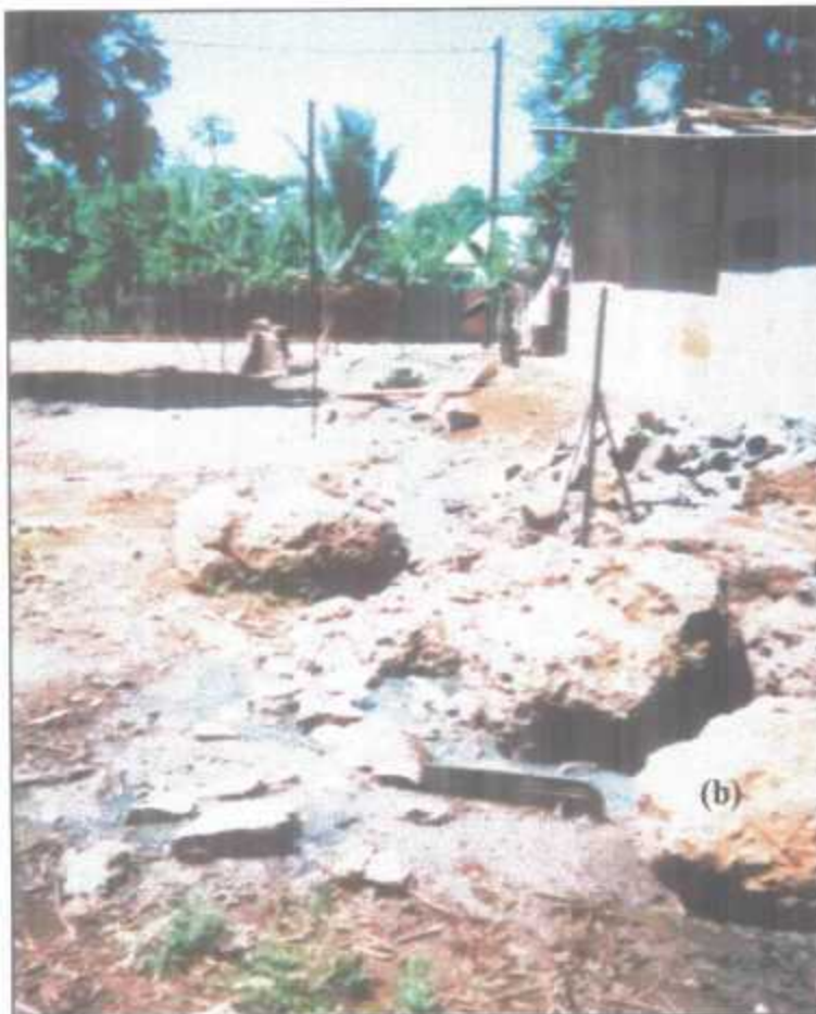
Figure 7 : (a) vue générale de la source Massimoni dans sa partie aval ; (b) zone d'évacuation du trop-plein du bassin (septembre 2000).
