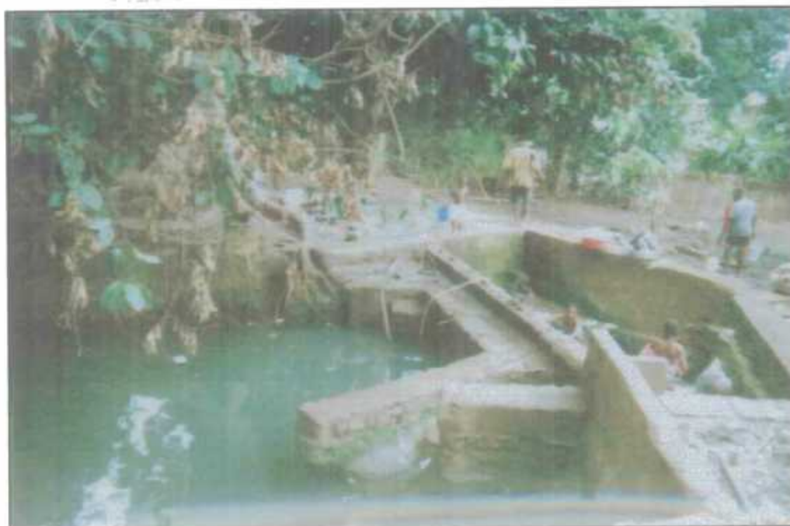
(b) Vue détaillée de l'ouvrage et du point d'émergence
