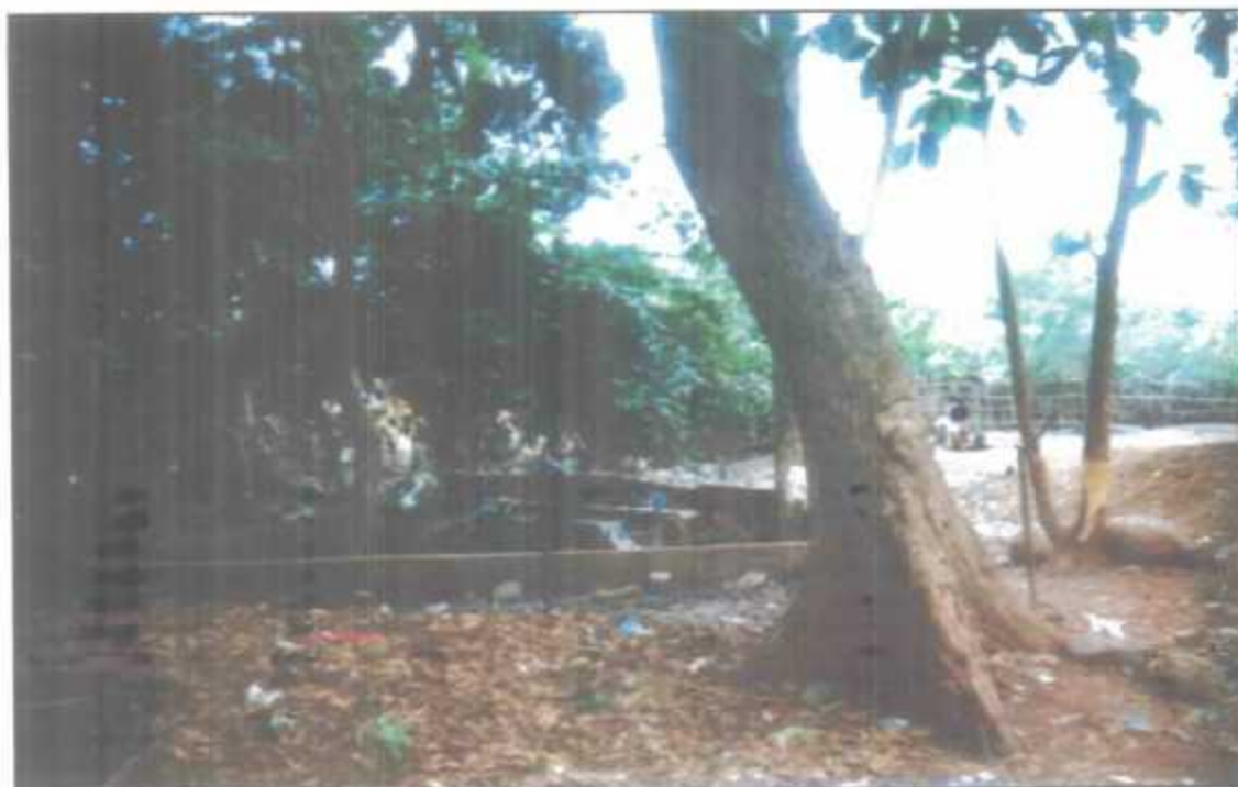
(a) Vue amont du captage
