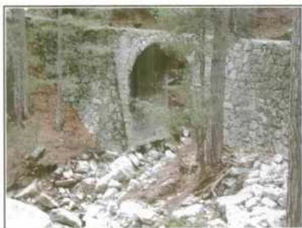
Affouillement de la culée rive droite
