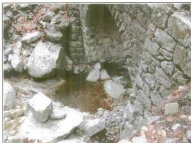
Léger affouillement de la culée rive gauche amont.
