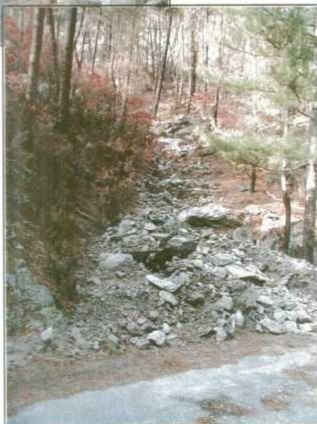
Petit dépôt au niveau d'un talweg
