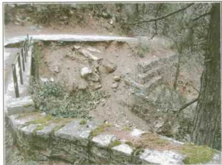
Effondrement du remblai d'accès en rive gauche par érosion de pied.
