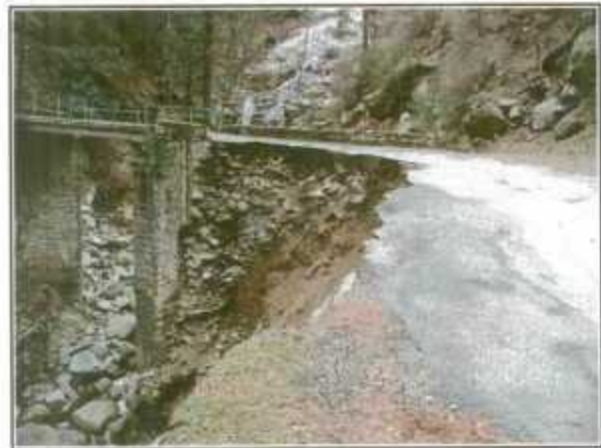
Effondrement du remblai d'accès en rive gauche par érosion de pied.
