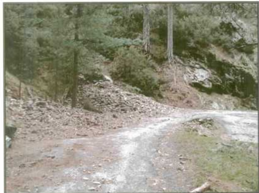
Petit dépôt au niveau d'un talweg
