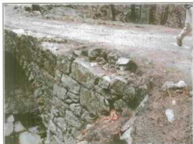
Léger affouillement de la culée rive gauche amont.
