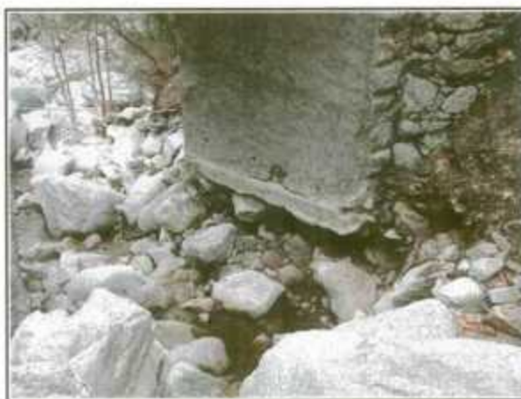
Affouillement de la culée rive droite
