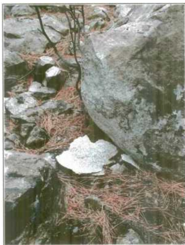
Eclatement en pelure d'oignon de blocs de granite sous l'effet de la chaleur.
