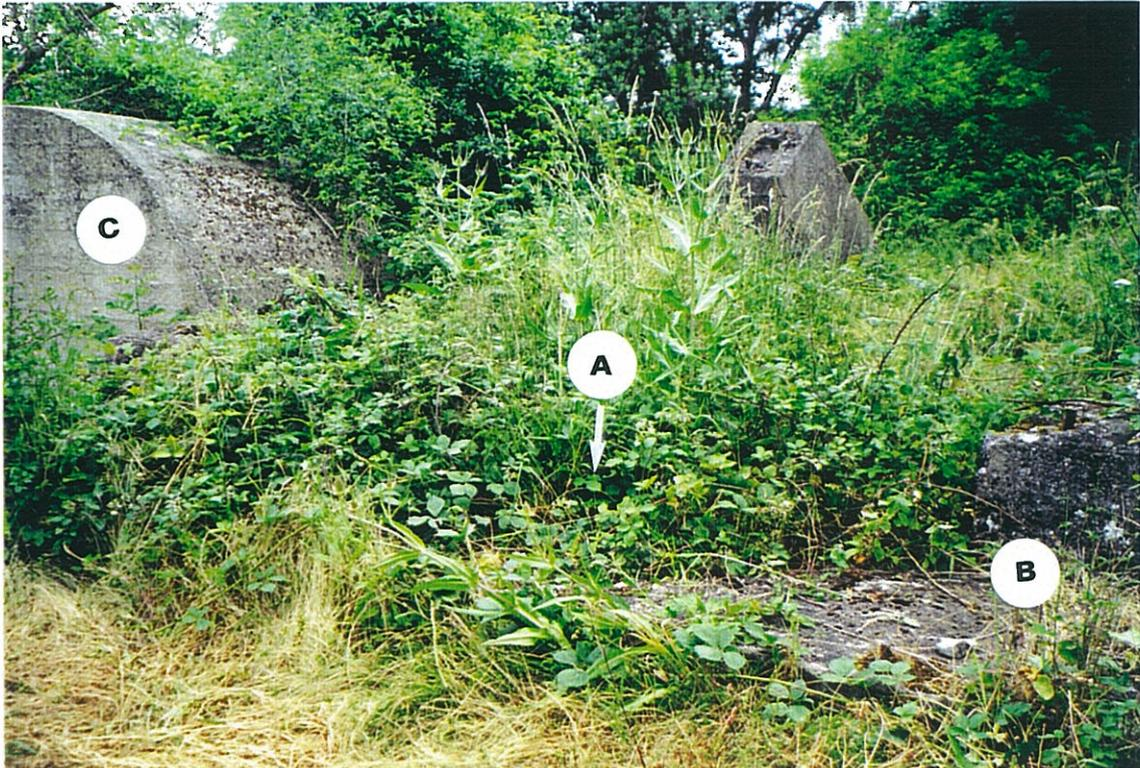
*Photo 6 - Fumichon - Puits 1 - A) Emplacement dans les ronces, B) Plots d'ancrage du chevalement et dalle béton autour du puits, C) Cabine du ventilateur.*
