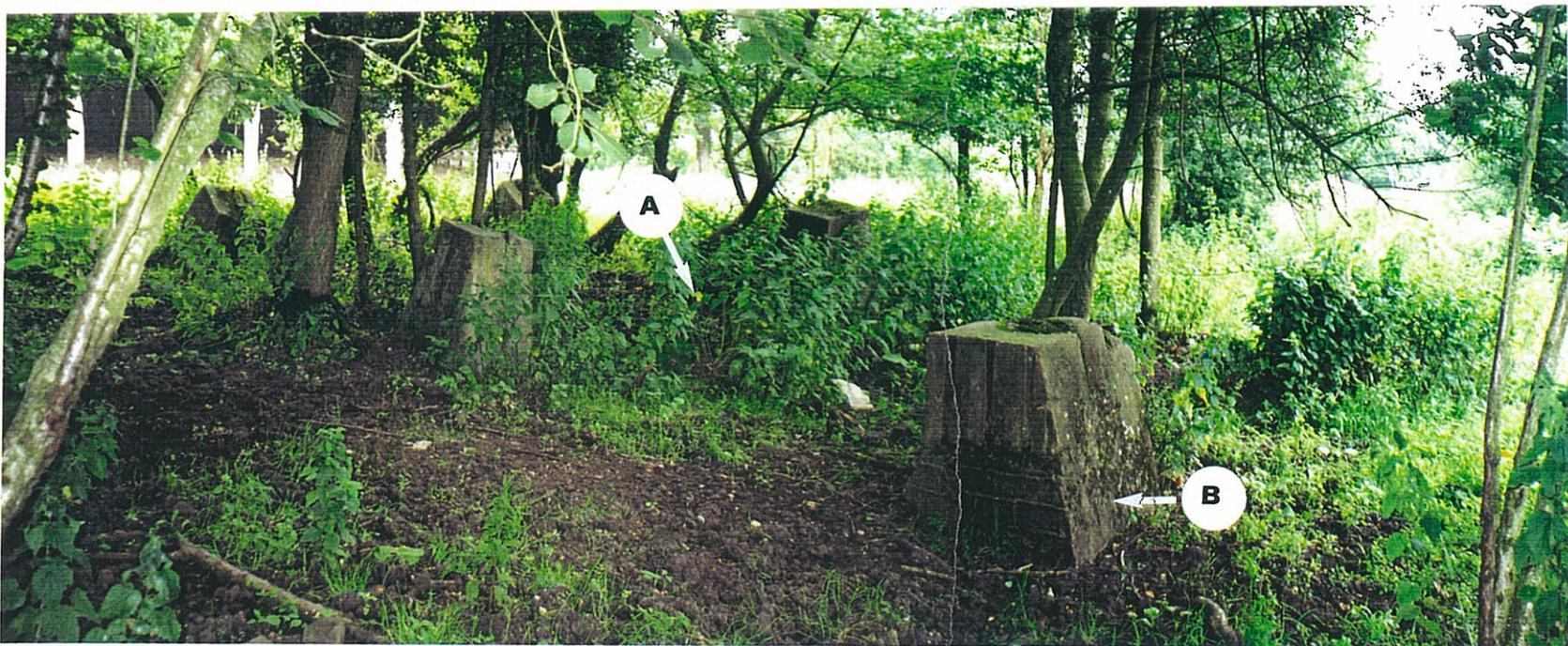
*Photo 10 - Fumichon - Puits 2. A) Emplacement du puits, B) Plots du chevalement.*
