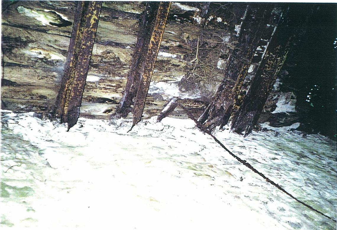
*Photo 16 - Fumichon - Les poutres métalliques du tablier ne sont plus porteuses.*
