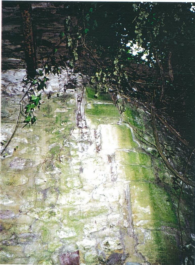
*Photo 17 - Fumichon - Fissure dans le mur de soutènement sous la poussée du talus.*
