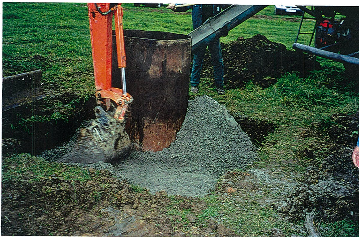
Photo 12 - Mise en place du bouchon de béton de 3,5 m 3 (environ 8 t).
