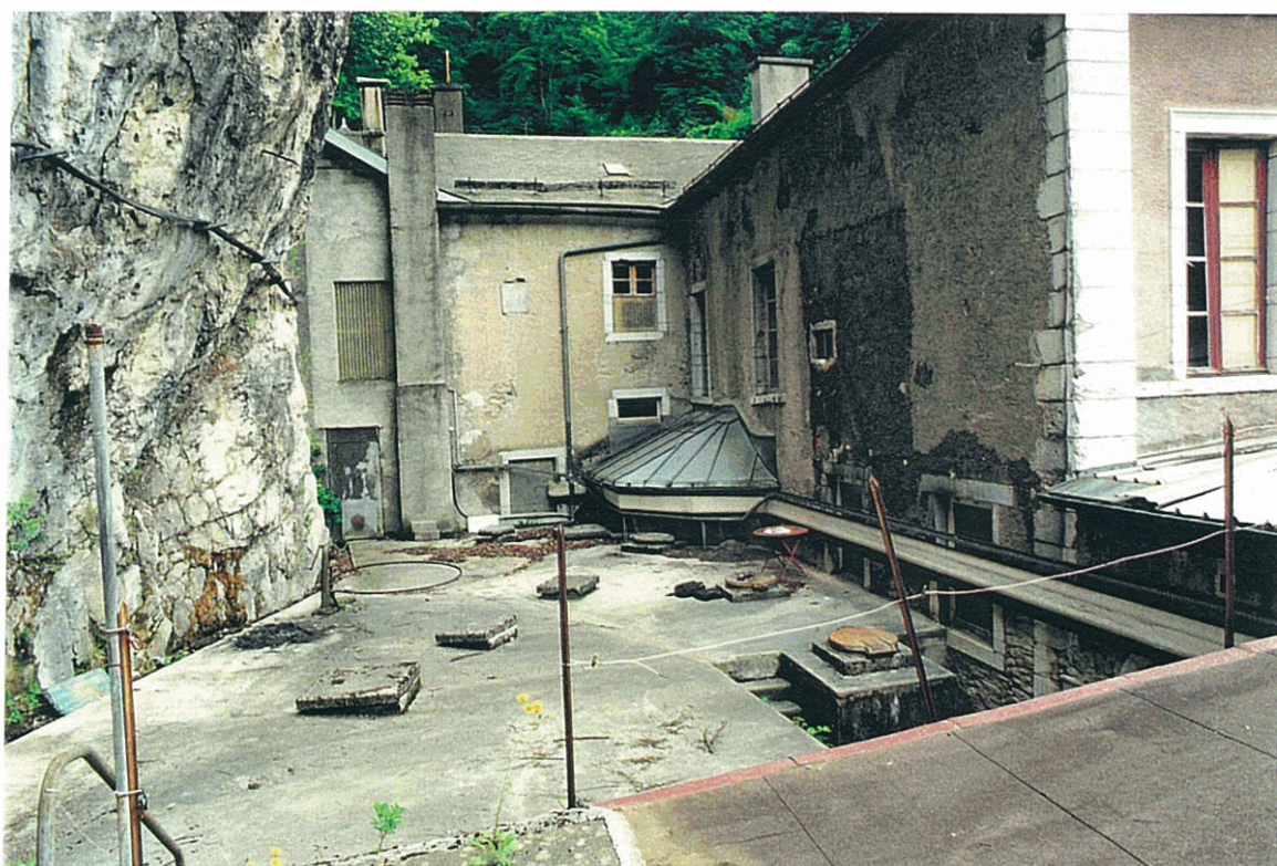
Photo n° 6 - Etablissement thermal cour intérieure. Vue côté sud
