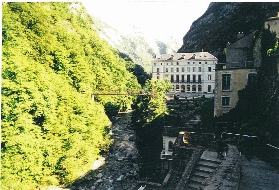
Photo n°1 Etablissement thermal des EAUX-CHAUDES vue générale
