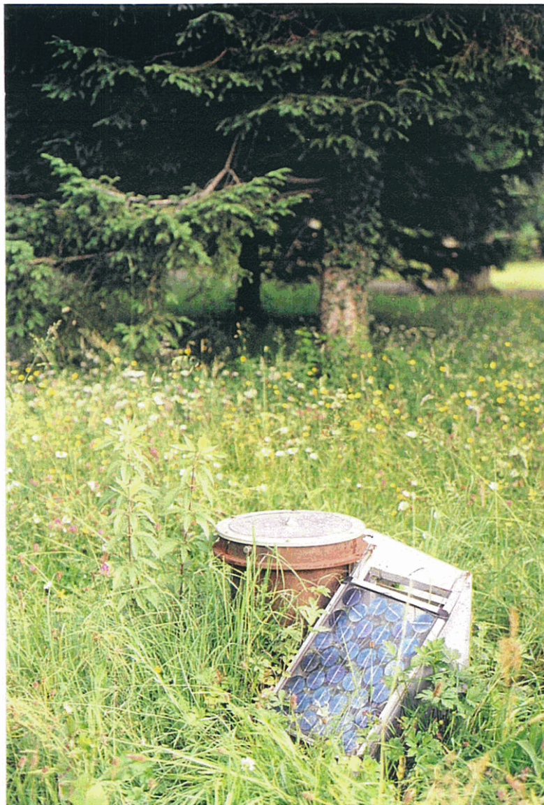
Photo n° 6 - Forage SC8 La Chapelle 1051-2x-0039
