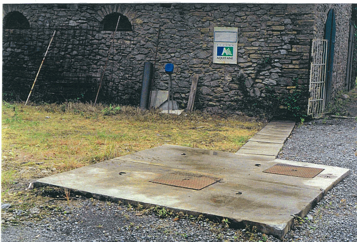
Photo n°7 - Forage SC9 1051-2X-0032 La Commanderie sud
