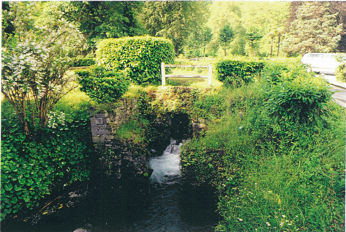
Photo n° 2 - Exutoire de la source des arceaux
