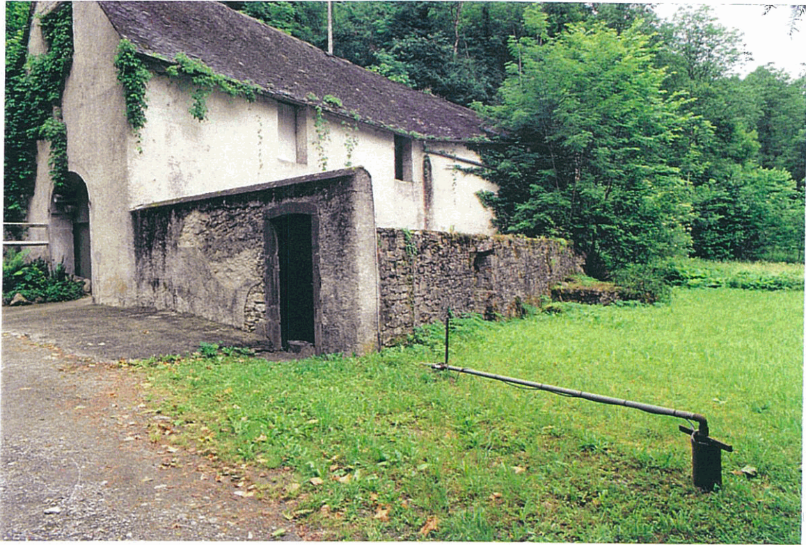
Photo n° 1 - Forage F1 1051-2X-0033. Au second plan, bâtiment avec source des Arceaux
