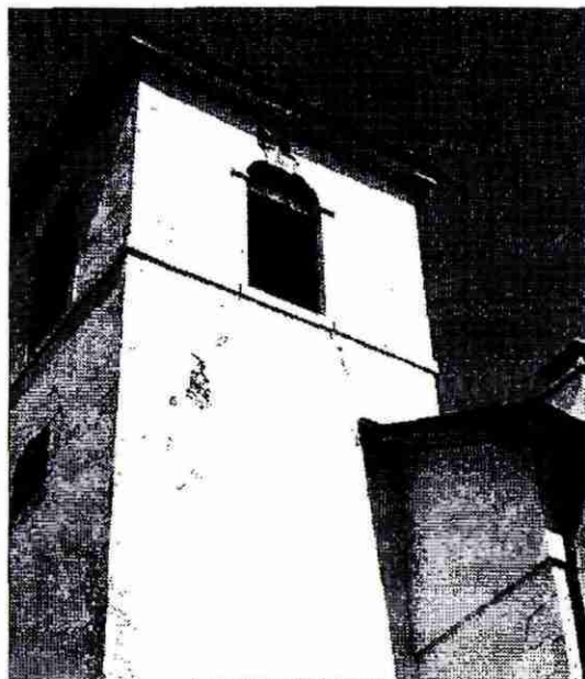
Clocher d'Epagny endommagé
