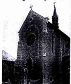
Les dégâts à la halle sportive et à l'église. Le séisme de Metz-Tessy a été particulièrement meurtrier par la violence de l'onde de choc. Des vitres ont volé en éclats, des meubles ont été renversés, des personnes ont été blessées. Les dégâts matériels ont été importants.
