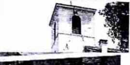
La secousse tellurique abîme l'église. Les dégâts à l'église d'Epagny sont importants. Le toit est effondré et les murs sont fissurés.
