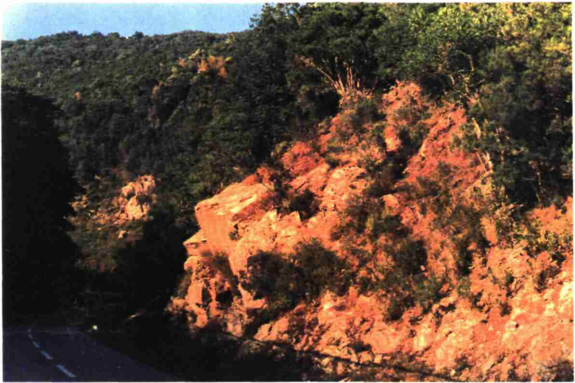
P.M. 650 à 750 _ Talus de grès à gros bancs
