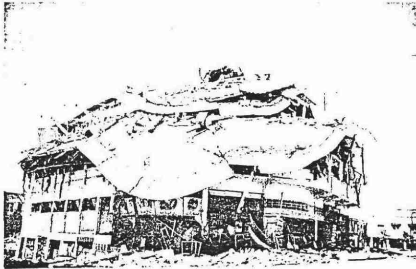
— Effondrement de l'immeuble Sud-Building, à Agadir (1960) Les étages supérieurs, trop lourds, mal soutenus ou mal liés ont écrasé la partie inférieure du bâtiment.
