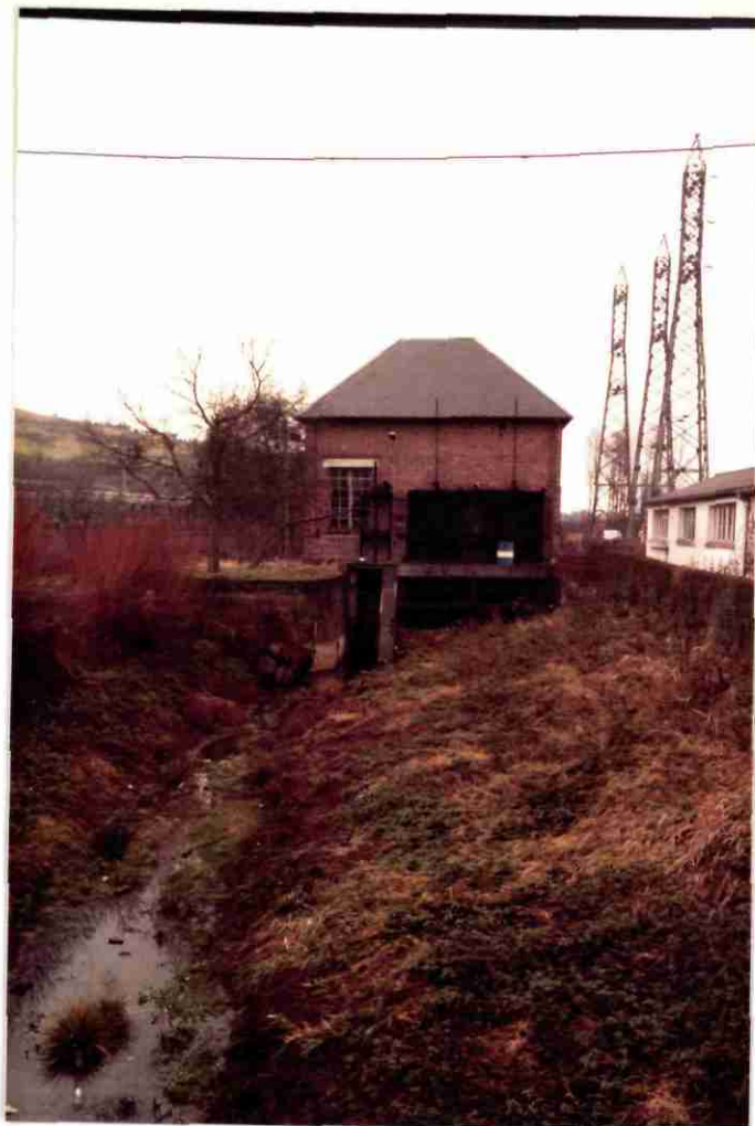
Aval du pont
