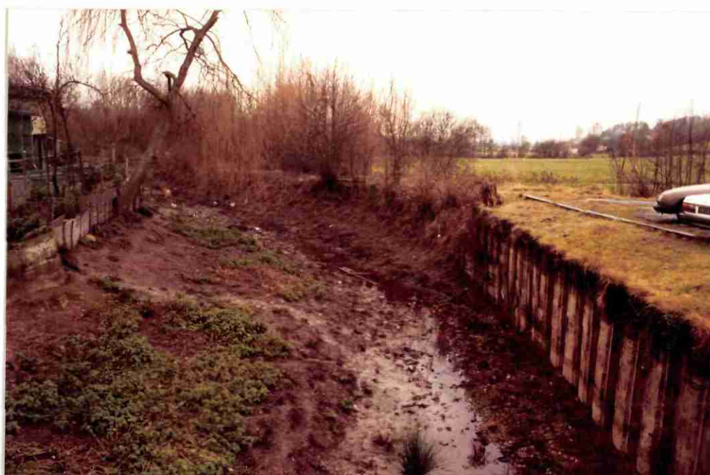
Amont du pont
