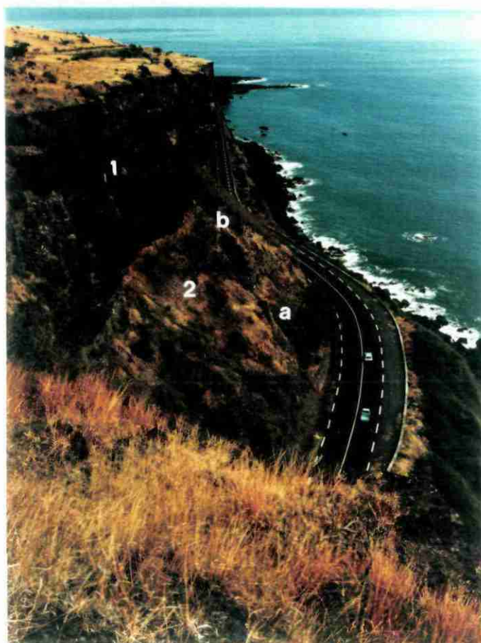
Fig. 9 - Aspect général avec 1 - falaise (basaltes, scories et brèches) 2 - talus naturel entaillé par la route a - arrachement ancien b - chaos rocheux
