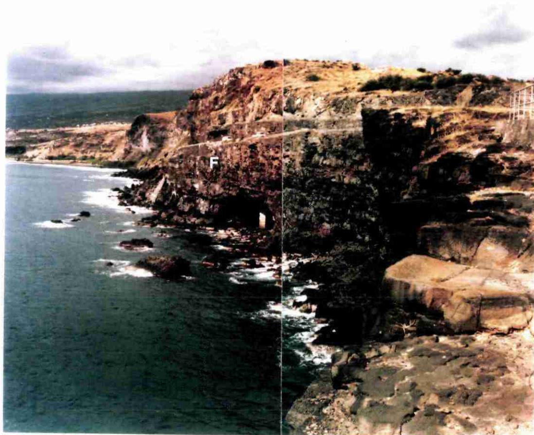
Fig. 14 - Vue d'ensemble avec caverne en-dessous de la route et renforcée par un pilier
