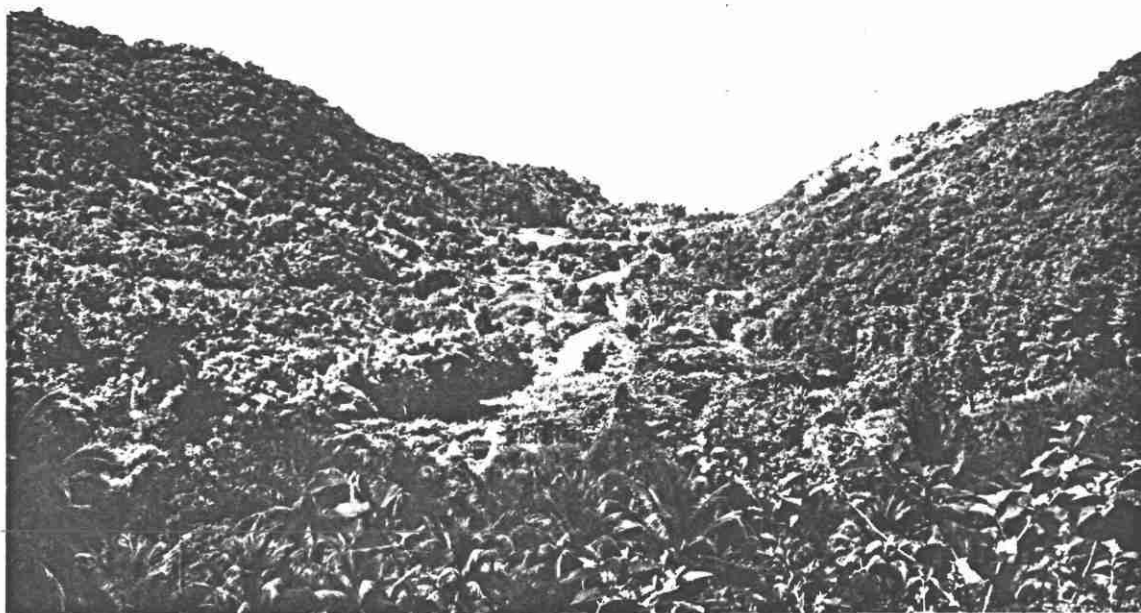
Exutoire du bassin versant du Carbet
