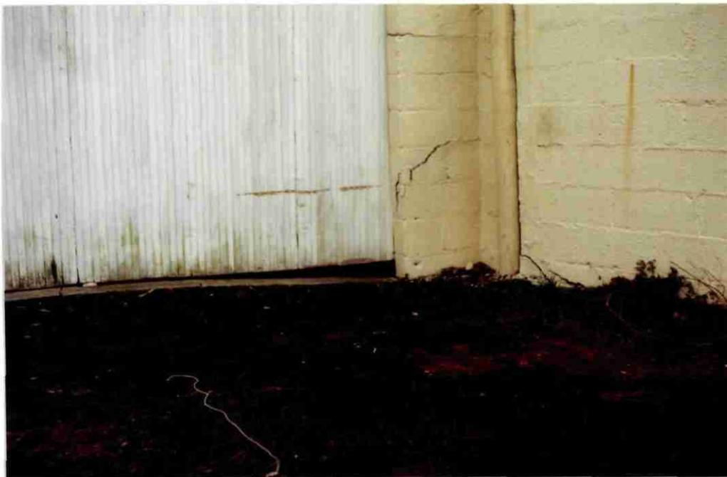
Photo 4 : VINEUIL-SAINT-FIRMIN. Mouvements de terrain dus à la présence de cavités souterraines
