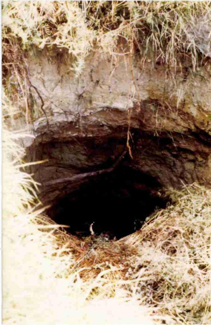
Photo 3 : Excavation due à la présence de souterrains creusés dans les Sables de Cuise à CREIL.
