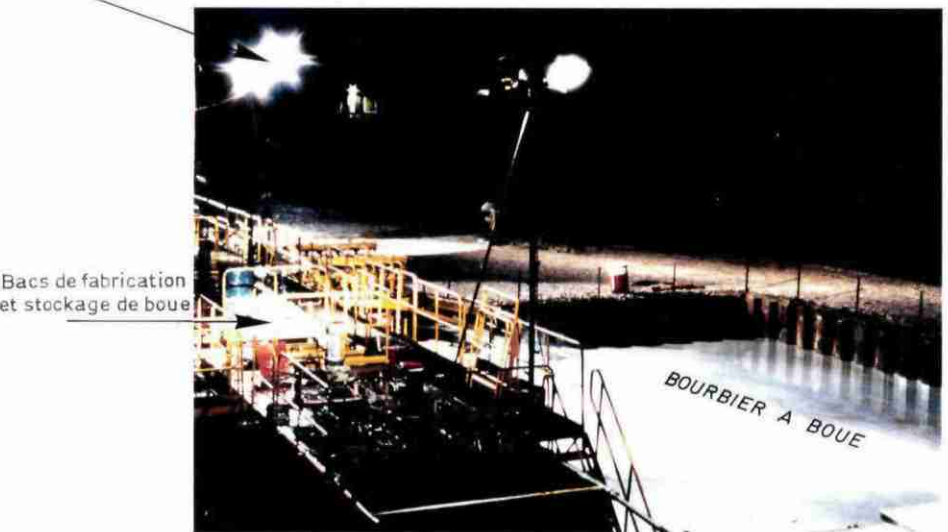
- Aspect du chantier de nuit
