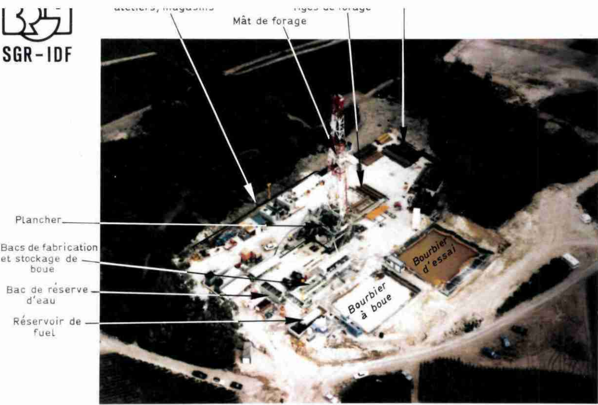
- Vue d'ensemble d'une plateforme de forage géothermique
