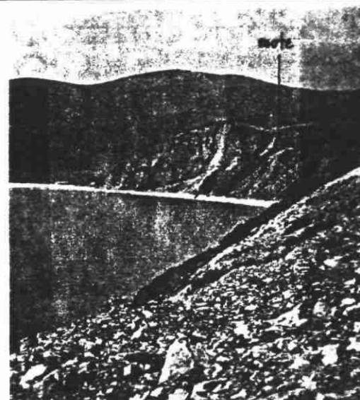
b. Eroulement de calcaires en plaques le long de la rade de JAZ, entre BUDVA et TIVAT sur la côte adriatique, à environ 40 km de l'épicentre. Le mouvement s'est fait à la faveur de glissements le long des plans de stratification (photo P. GODEFROY, B.R.G.M.)
