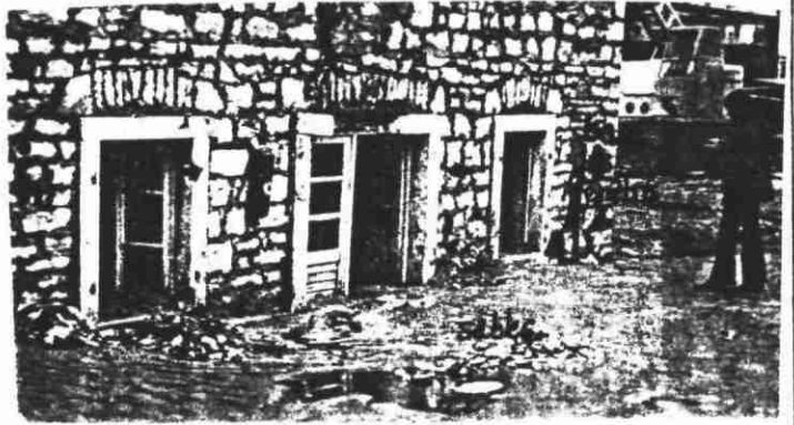
b. Enfouissement d'une maison dans la région de BIJELA, consécutif à une liquéfaction de sables, en bordure de mer (photo G. WIECZOREK, U.S.G.S. Menlo Park)
