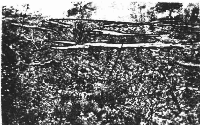
d. Glissement dans les flyschs paléogènes de la région de KALIMAN, près de la frontière albanaise, à une vingtaine de km de l'épicentre. Ce glissement a affecté une zone d'environ 1 km de long et 300 mètres de large, sur une profondeur atteignant 20 mètres. Le volume concerné est de l'ordre de 6 millions de m^3 (photo G. WIECZOREK, U.S.G.S. Menlo Park)
